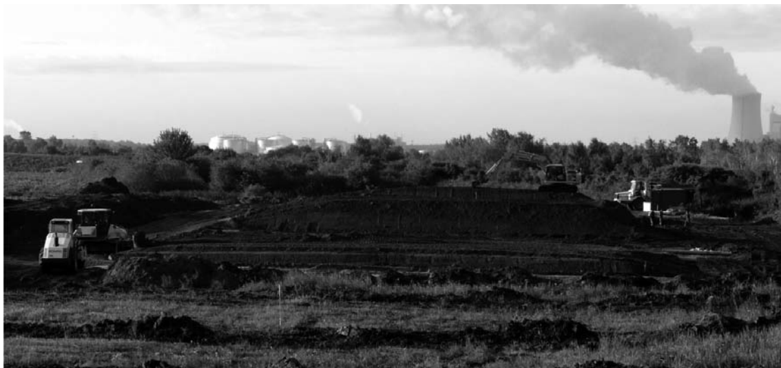
Rys. 7. Budowa wałów poprzecznych w sierpniu 2011 r.
