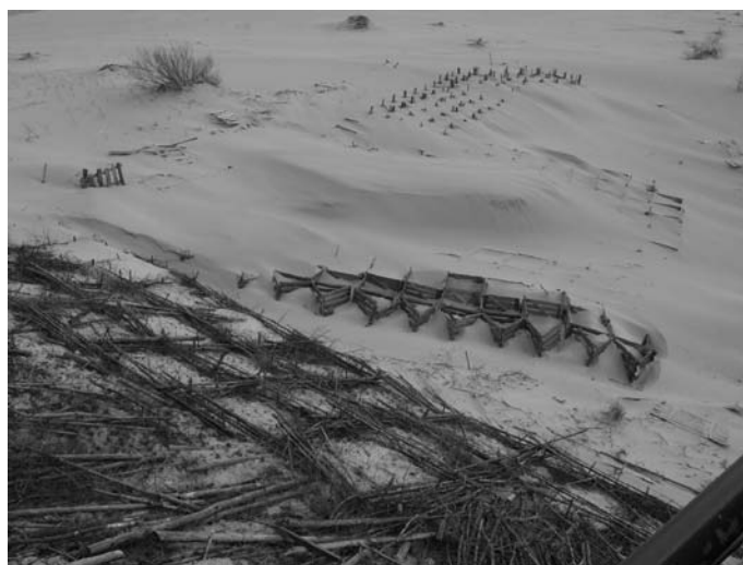
Rys.13. Stabilizacja ruchomych piasków na Mierzei Kurońskiej za pomocą wydmywających mat i płotków
