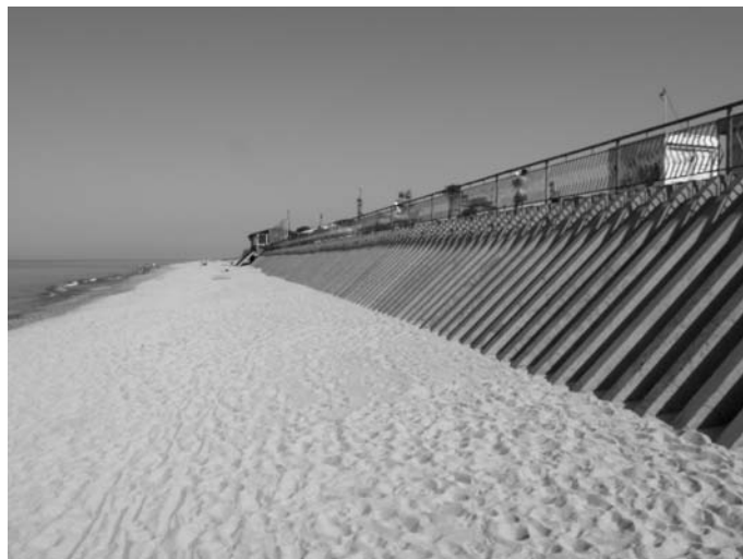
Rys. 12. Opaska brzegowa w miejscowości Lesnoj
