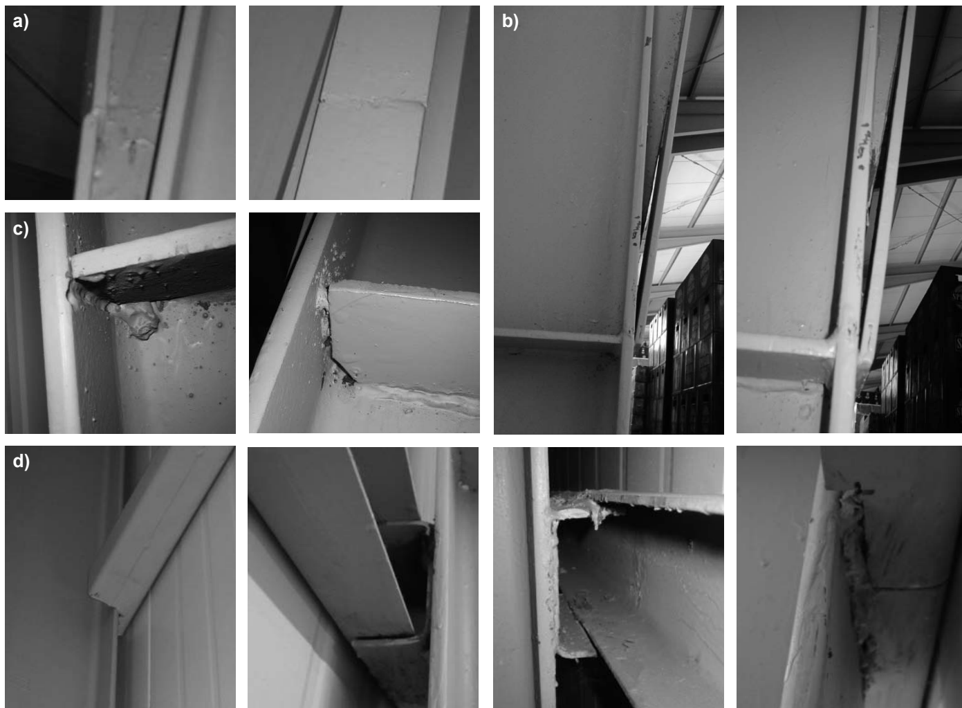
Rys. 2. Wybrane defekty wykonawcze obiektu o stalowej konstrukcji nośnej a) pęknięcie pasa dolnego w obrębie węzła, b) przykłady złego wykonania wzmocnienia, c) wady połączeń spawanych, d) przykłady łączenia elementów oryglowania ściennego do słupów konstrukcyjnych
