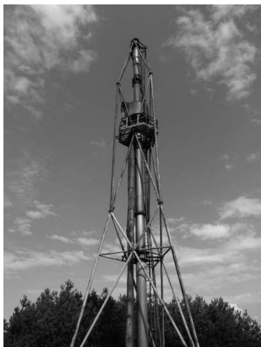
Rys. 8. Widok ogólny obiektu
