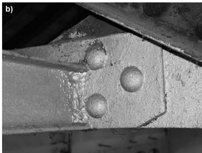
Rys. 3. Węzły konstrukcyjne stalowych więzów kratowych w miejscu połączenia prętów dodatkowych oraz istniejącej konstrukcji a) połączenie krzyżulców wewnętrznych środkowych z pasem dolnym – A, b) w miejscu połączenia konstrukcji nośnej sufitu podwieszanego – połączenie I 80 mm w miejscu krzyżowania się krzyżulca zewnętrznego, wewnętrznego oraz słupka wewnętrznego – B
