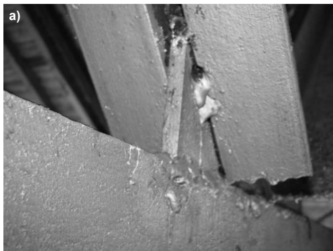
Rys. 3. Węzły konstrukcyjne stalowych więzów kratowych w miejscu połączenia prętów dodatkowych oraz istniejącej konstrukcji a) połączenie krzyżulców wewnętrznych środkowych z pasem dolnym – A, b) w miejscu połączenia konstrukcji nośnej sufitu podwieszanego – połączenie I 80 mm w miejscu krzyżowania się krzyżulca zewnętrznego, wewnętrznego oraz słupka wewnętrznego – B
