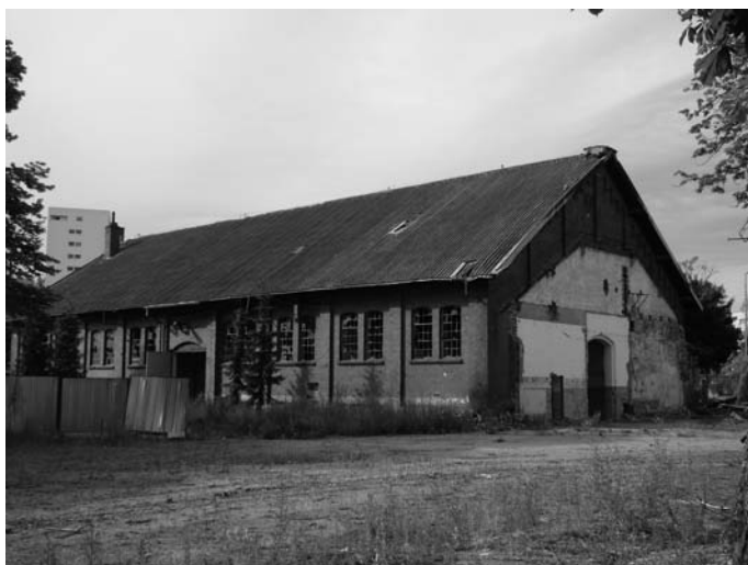
Rys. 1. Budynek Wozowni – stan istniejący
