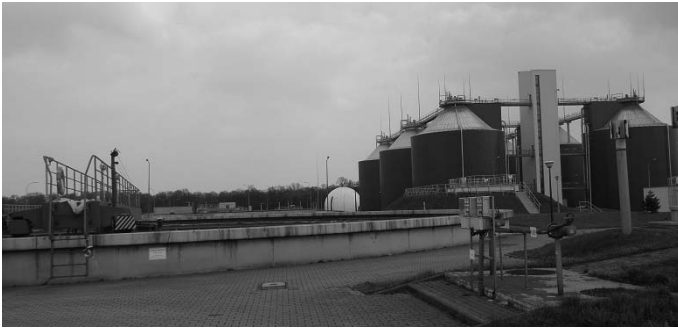
Rys. 9. Przerób osadów – zamknięte zbiorniki fermentacyjne, w głębi kuliste zbiorniki gazu
