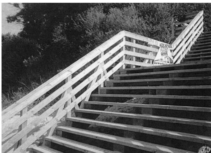
Rys. 5. Widok balustrady zrealizowanego zejścia w Sianożętach
