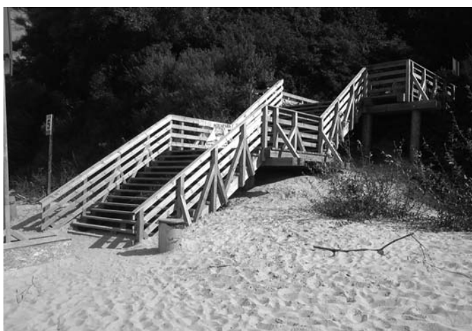
Rys. 6. Widok konstrukcji zrealizowanego zejścia nr 5
