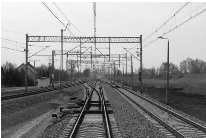
Rys. 3. Rozjazd typu 60E1-1200-1:18,5 na posterunku Gdańsk Święty Wojciech
