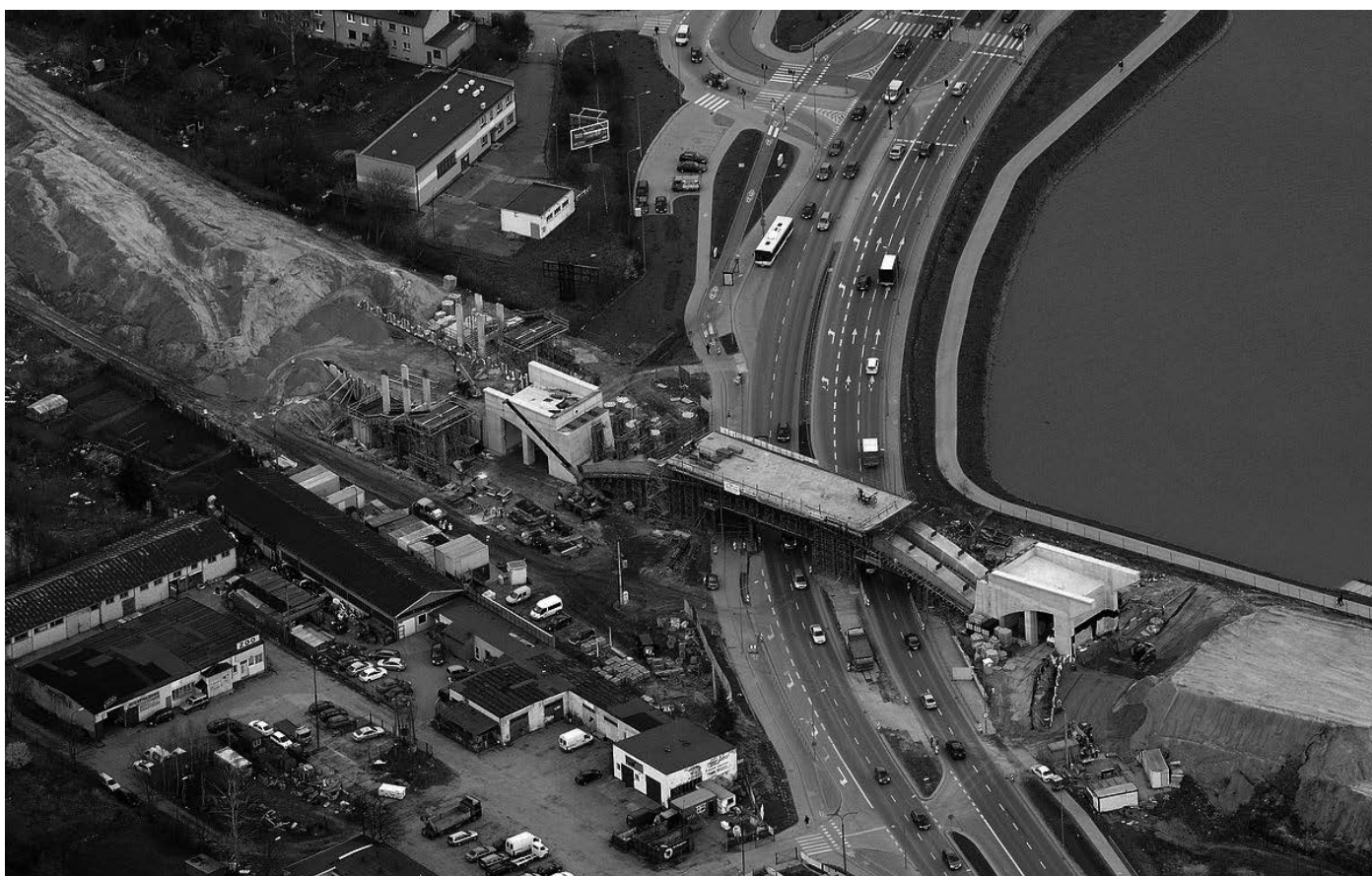
Rys. 4. Budowa wiaduktu WK11 nad ulicą Słowackiego w Gdańsku (źródło: PKM)
