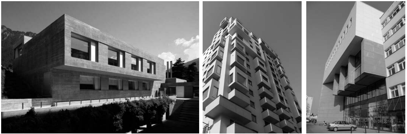
Rys. 1. Przykłady zastosowania tarcz wspornikowych
