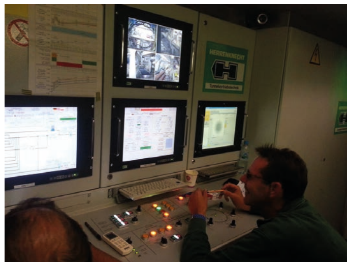
Rys. 1. Pomieszczenie sterujące maszyną TBM – Damroka, Gdańsk (fot. Marek Multan, Wojciech Smoleń)
