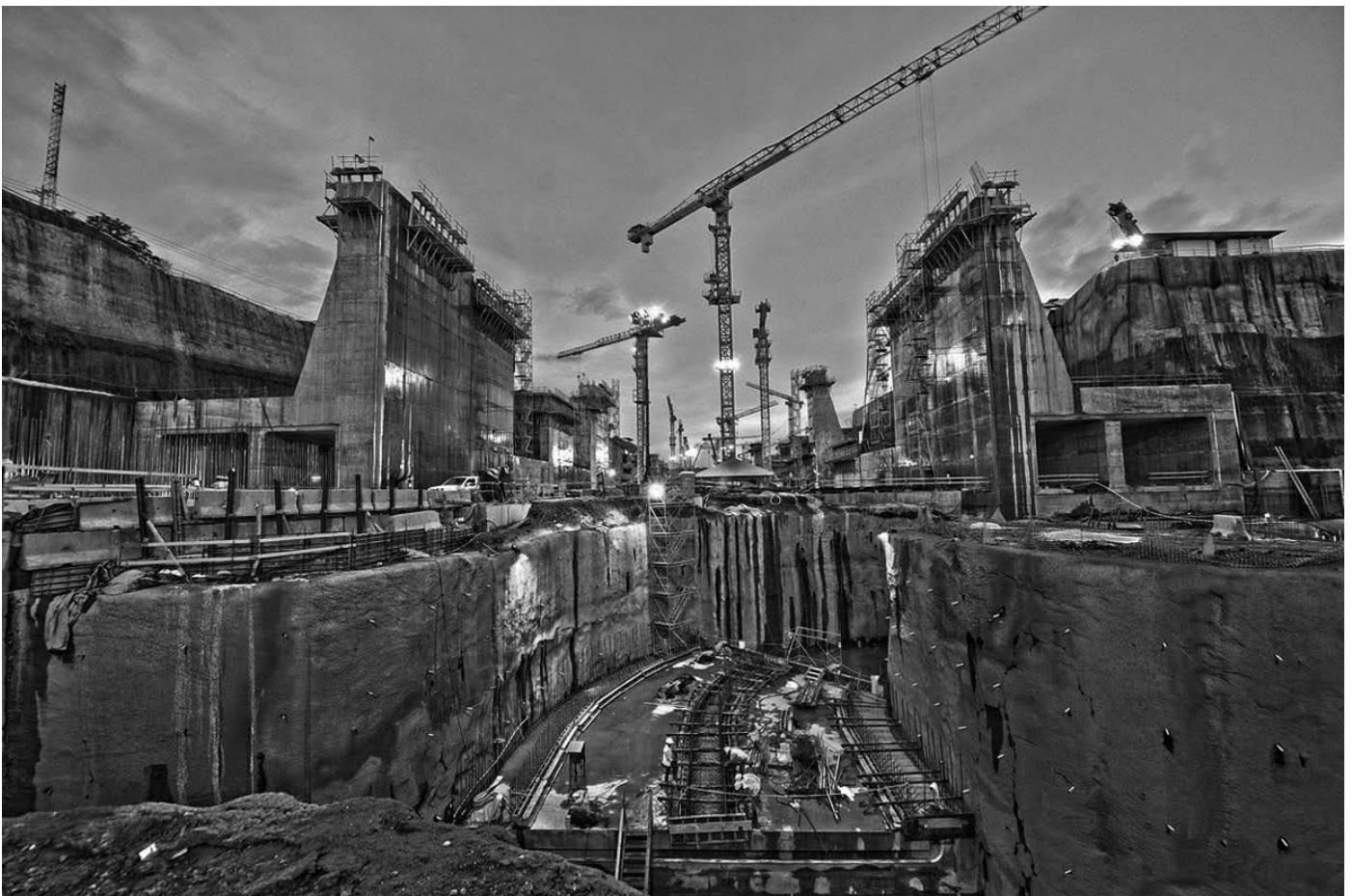
Rys. 6. Budowa koryta i wykop pod kanał do basenów przechwyty wody (z uprzejmości ACP)
