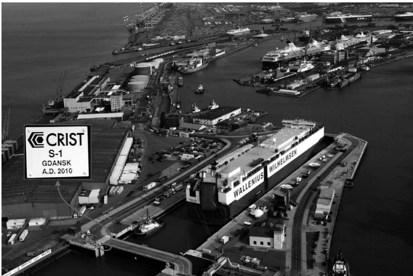
Rys. 11. Śluza Cesarska w Bremerhaven z wrotami wykonanymi w stoczni CRIST S.A. (na podstawie materiałów bremenports GmbH & Co. KG)
