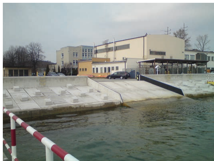
Rys. 14. Widok na pochylnię (z lewej strony widoczny bieg schodów)
