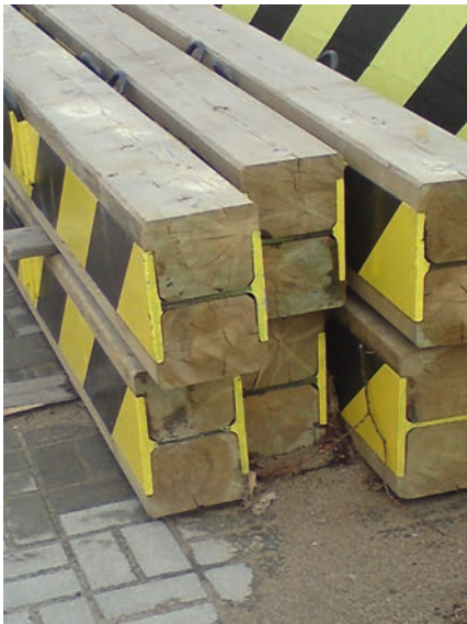
Rys. 15. Konstrukcja szandorów przeciwpożarowych
