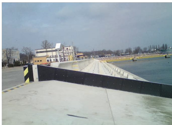
Rys. 12. Widok zrealizowanej opaski brzegowej (widoczny bieg schodów i klamry zejścia)
