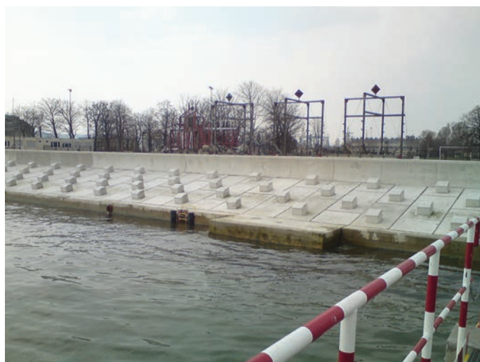
Rys. 13. Widok nadbudowy zrealizowanej opaski brzegowej (wyraźnie widoczne rozmieszczenie bloków szyszan usytuowanych na co drugiej płycie okładziny mijankowo w rzędach)
