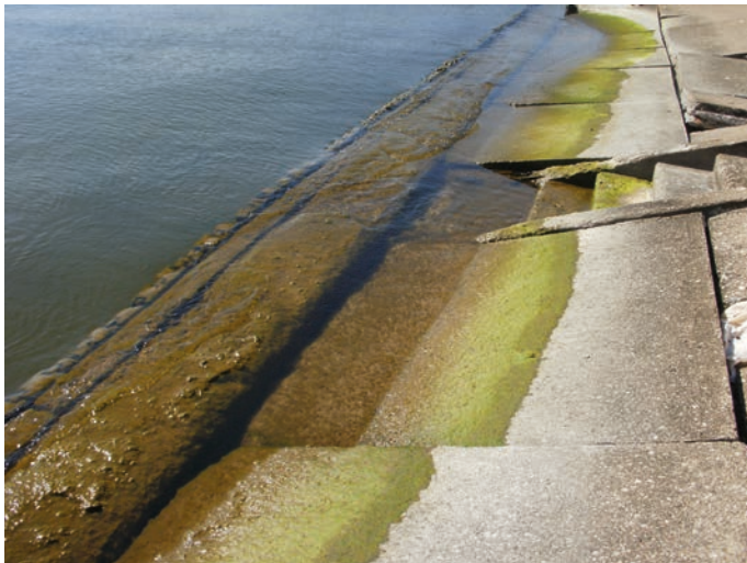
Rys. 2. Widok ogólny opaski brzegowej przed przebudową z 2011 roku
