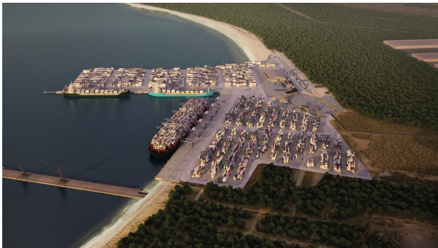
Rys. 5. Rozbudowa terminalu kontenerowego DCT Gdańsk (źródło: DCT Gdańsk SA)
