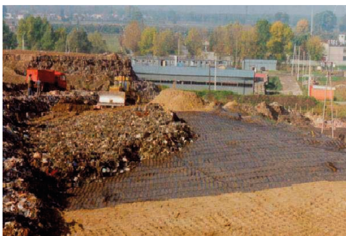
Rys. 2. Georuszt PE HD podczas instalacji na składowisku „Radiowo” (1993 rok) [6]
