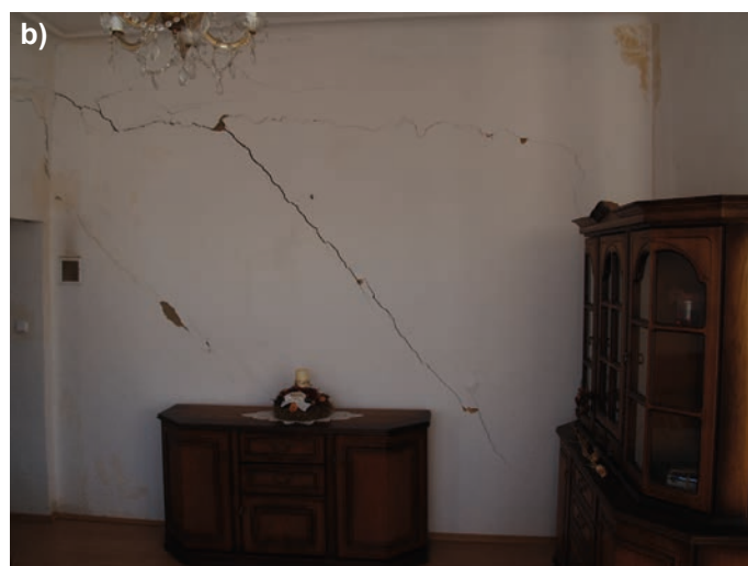
Rys. 3. Spękania ścian budynku powstałe wskutek aktywacji progu terenowego a) ściana przyziemia, b) ściana parteru
