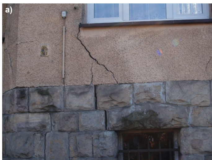
Rys. 3. Spękania ścian budynku powstałe wskutek aktywacji progu terenowego a) ściana przyziemia, b) ściana parteru
