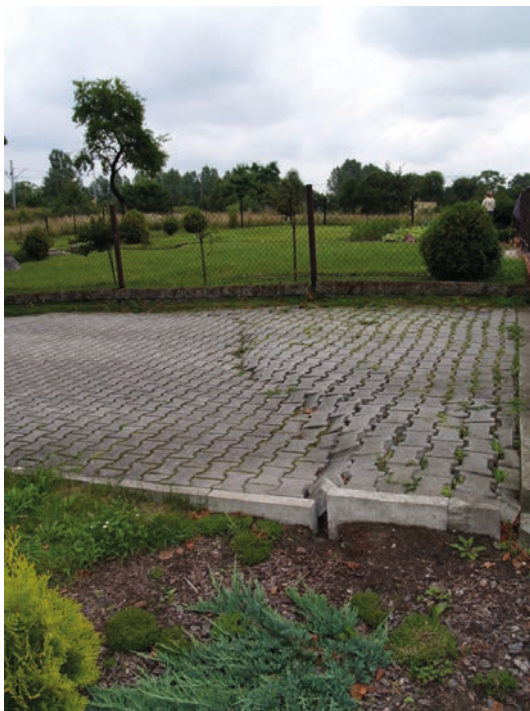
Rys. 1. Przykłady deformacji liniowych progów ujawnionych w terenie
