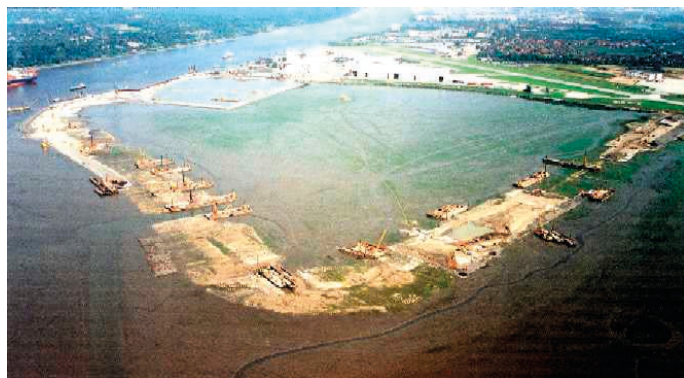
Rys. 8. Instalacja kolumn GEC's pod wał odcinający koryto Łaby, Teren Fabryki Airbus 380, Hamburg, 2001 (fot. Möbius)
