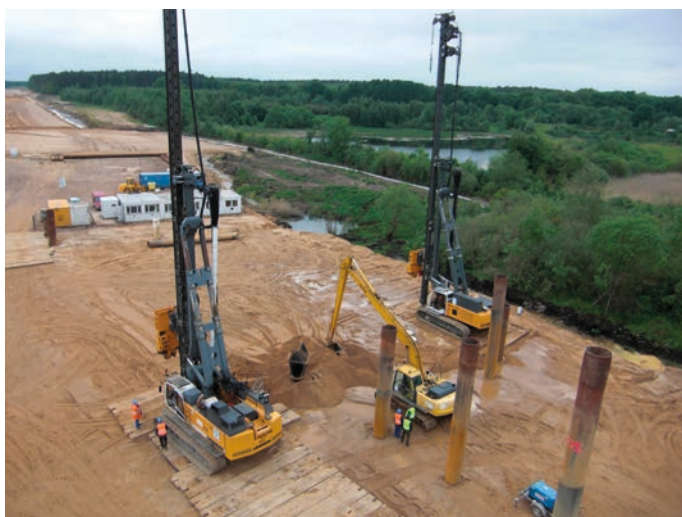
Rys.14. Palownice w trakcie instalacji kolumn, A2, km 60+220 ÷ 60+450 (fot. Möbius)
