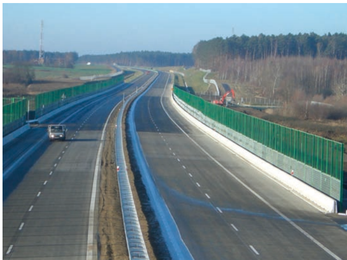
Rys. 22. Widok odcinka autostrady posadowionego na systemie GEC's, km 60+200 ÷ km 60+450 przed oddaniem do ruchu, listopad 2011 (fot. Huesker)
