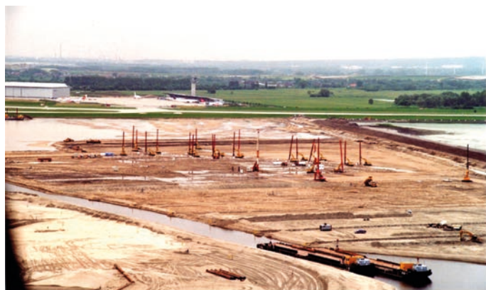
Rys. 9. Instalacja geosyntetycznego drenażu pionowego w rozstawie kwadratowym o oczku 0,50 m × 0,50 m na platformie roboczej (fot. Huesker)
