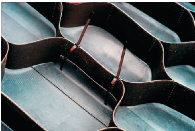
Rys. 1. Sposób mocowania geokraty do geomembrany za pośrednictwem dospawanej szykany w systemie GeoQiube
