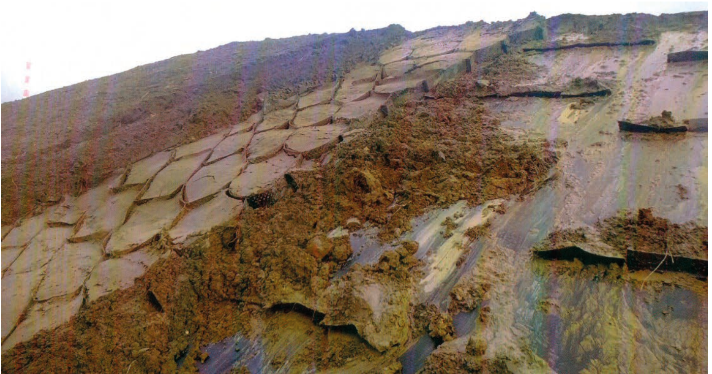
Rys. 3. Osuwisko powierzchniowe na skarpie ubezpieczonej systemem GeoQiube
