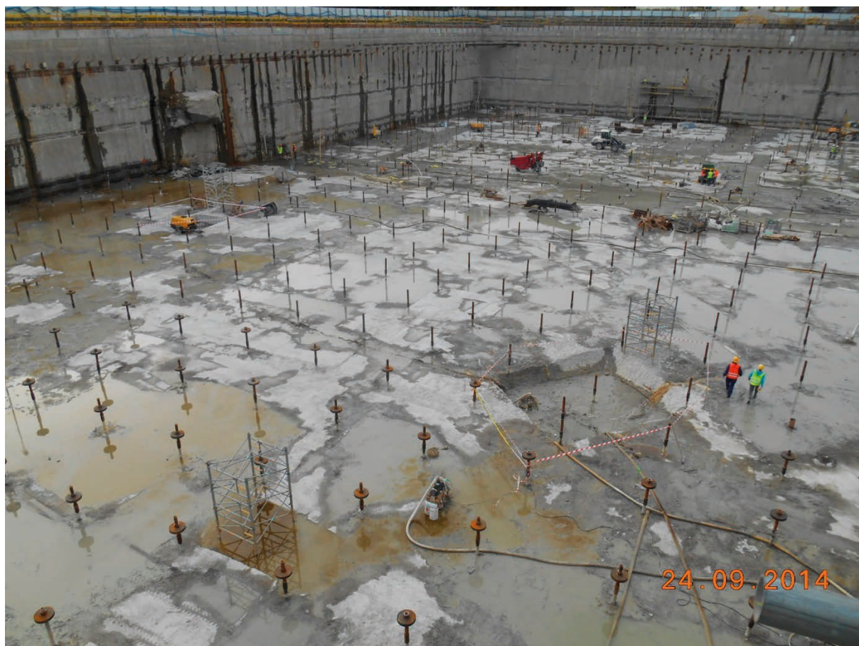
Rys. 3. Widok płyty korka po odpompowaniu wody (Soletanche Polska)
