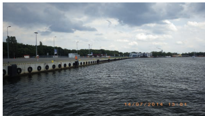
Rys. 15. Nabrzeże Obrońców Westerplatte (2014) po przebudowie
