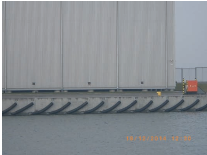
Rys. 4. Nabrzeże Połączeniowe (2014) – zmodernizowana ściana odwodna nabrzeża z nową linią odbojową
