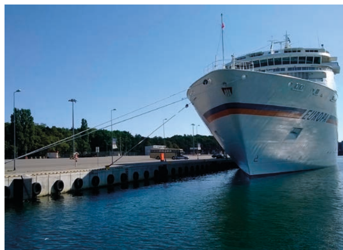
Rys. 16. Nabrzeże Obrońców Westerplatte (2014) po przebudowie
