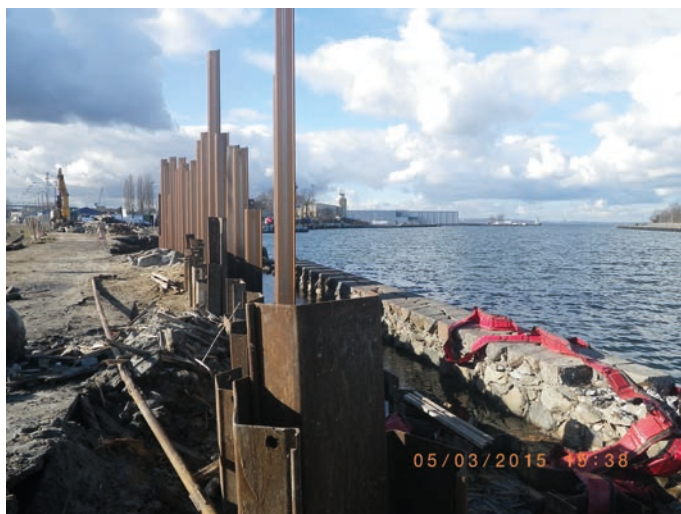
Rys. 9. Nabrzeże Oliwskie (2015) – trwają prace związane z przebudową odcinka o długości 100 m.b.
