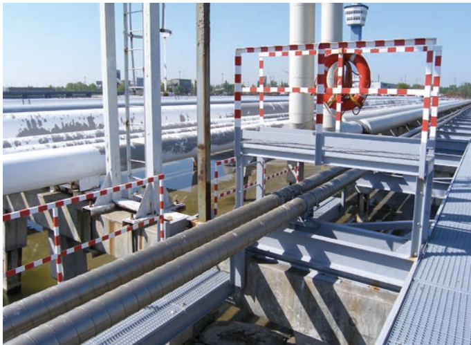
Rys. 24. Estakada pod rurociągi paliwowe – po wykonaniu zabezpieczenia antykorozyyjnego
