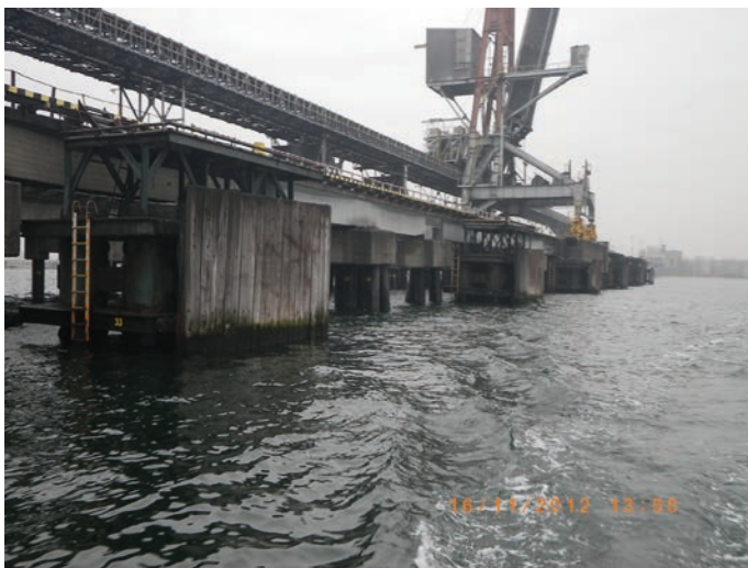
Rys. 25. Pirs Węglowy (2012) – przed modernizacją dalb odbojowych
