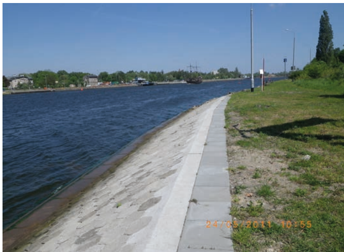
Rys. 17. Nabrzeże Wisłoujście (2011) – nabrzeże skarpowe
