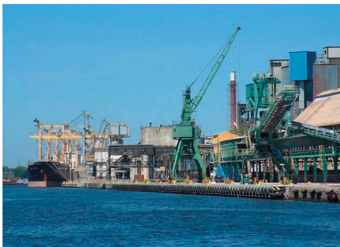
Rys. 18. Nabrzeże Przemysłowe – odcinek III-1 po przebudowie (lewa część) oraz odcinek III-2 przed przebudową (prawa część)
