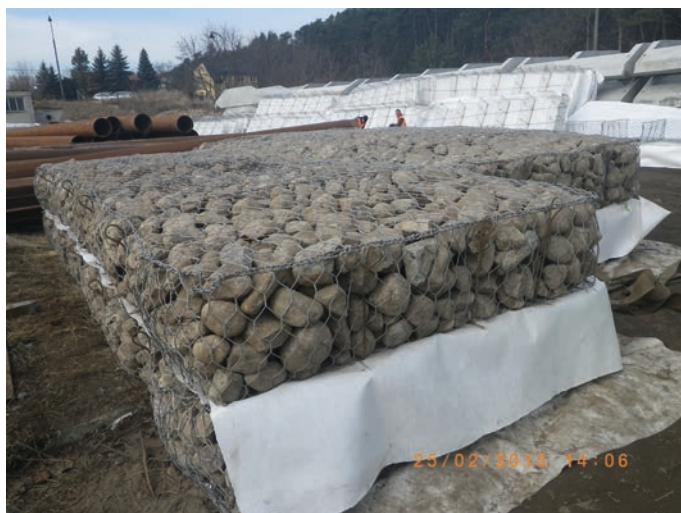
Rys. 6. Nabrzeże WOC I w Basenie Władysława IV (2015) – gabiony przygotowane do wbudowania w dno przy Nabrzeżu
