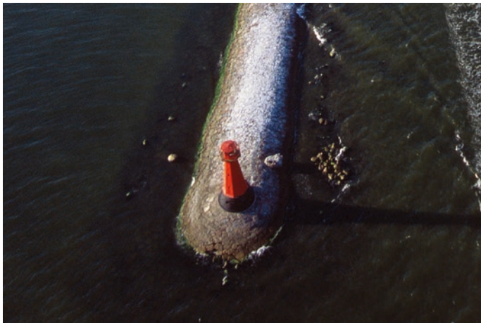
Rys. 2. Głowica Falochronu Wejściowego Wschodniego – wejście do Portu Gdańsk – przed przebudową
