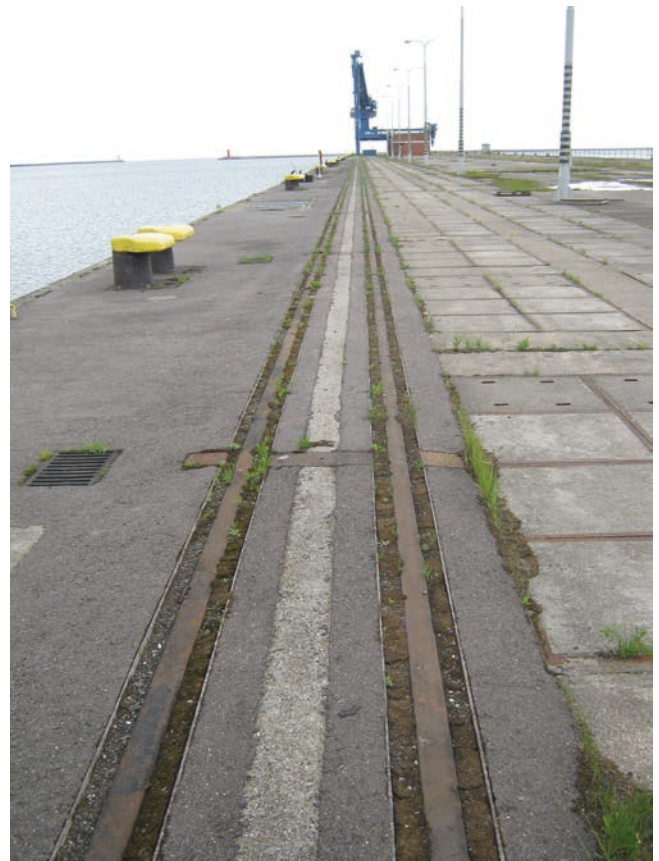
Rys. 27. Pirs Rudowy przed remontem nawierzchni na pirsie
