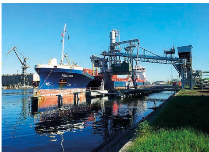
Rys. 19. Nabrzeże Bytomskie – stanowisko dalbowe (fot. GBT)
