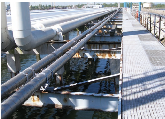
Rys. 23. Estakada pod rurociągi paliwowe – przed wykonaniem zabezpieczenia antykorozyjnego
