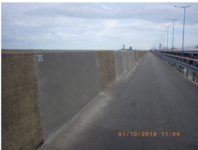
Rys. 22. Falochron Półwyspowy Północny (2014) – po wymianie nawierzchni
