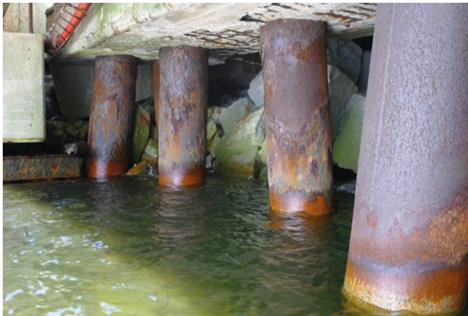
Rys. 29. Pirs Rudowy przed wykonaniem ochrony antykorozyjnej
