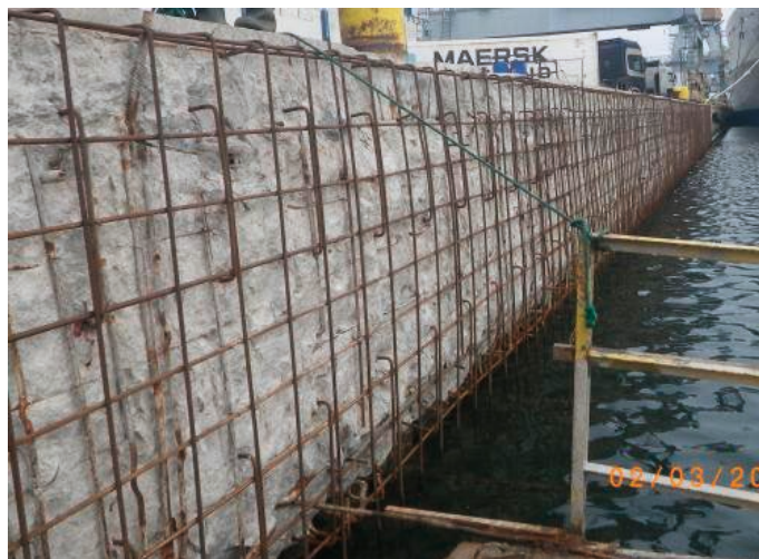
Rys. 5. Nabrzeże WOC I w Basenie Władysława IV (2015) – trwają prace związane z modernizacją ściany odwodnej
