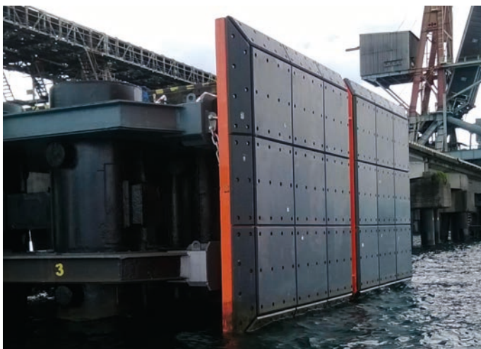
Rys. 26. Pirs Węglowy (2012) – po modernizacji dalb odbojowych
