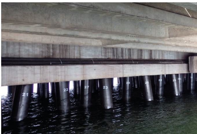
Rys. 30. Pirs Rudowy w trakcie wykonywania ochrony antykorozyjnej
