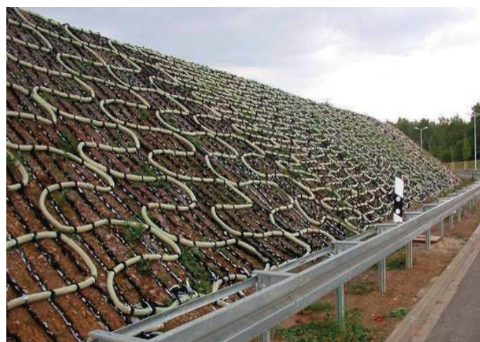
Rys. 2. Skarpa zbrojona innowacyjnymi geotekstyliami [6]
