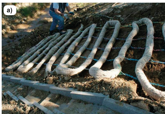
Rys. 7. Montaż meandrycznych geotekstyliów na skarpie a) rozłożony segment na powierzchni skarpy, b) mocowanie geotekstyliów do gruntu
