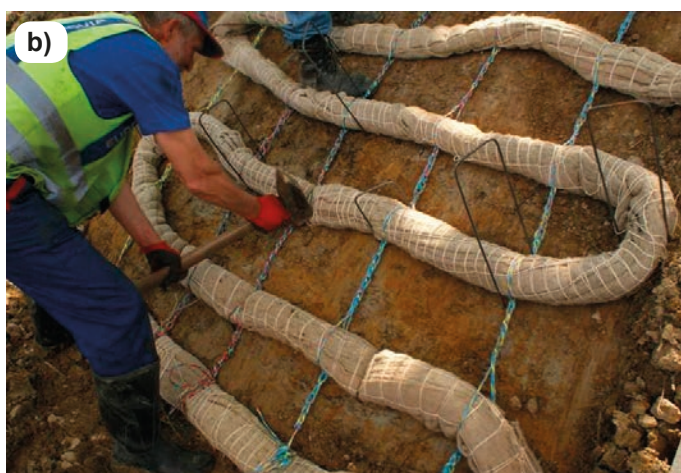
Rys. 7. Montaż meandrycznych geotekstyliów na skarpie a) rozłożony segment na powierzchni skarpy, b) mocowanie geotekstyliów do gruntu
