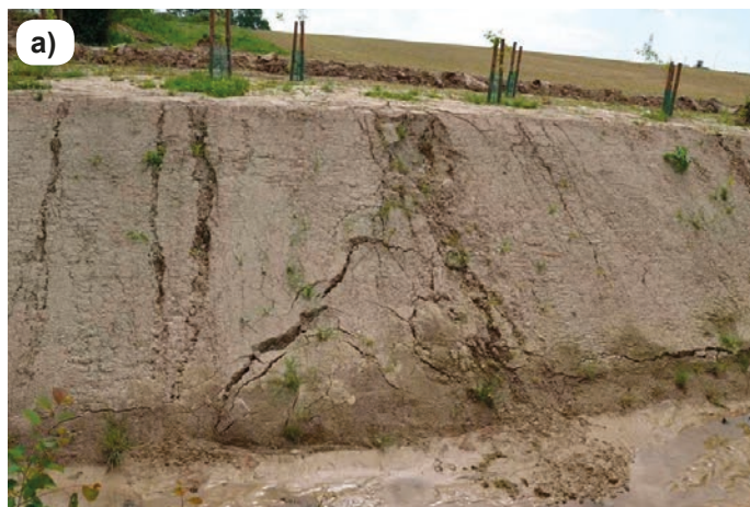
Rys. 6. Rów odwadniający po zabiegach wyrównujących a) wyłobienia spowodowane erozją, b) obsuwanie brzegów
