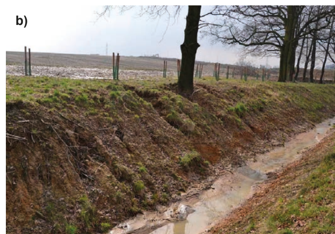
Rys. 5. Teren Jasienickiej Strefy Ekonomicznej a) rów odwadniający, b) erozja brzegów rowu odwadniającego
