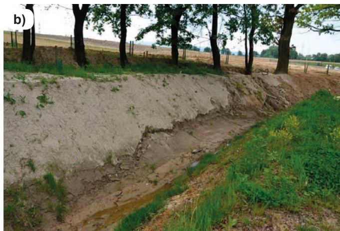
Rys. 6. Rów odwadniający po zabiegach wyrównujących a) wyłobienia spowodowane erozją, b) obsuwanie brzegów
