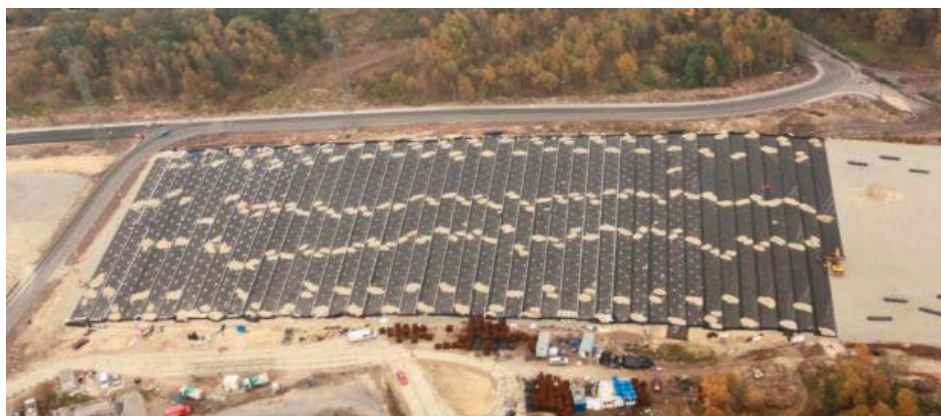
Rys. 9. Zdjęcie lotnicze budowy autostrady A1 – widoczne ułożone i zakotwione zbrojenie geosyntetyczne wraz z drugim systemem monitoringu
