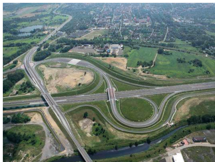
Rys. 11. Oddany do użytku fragment autostrady A1 – węzeł Piekary Śląskie
