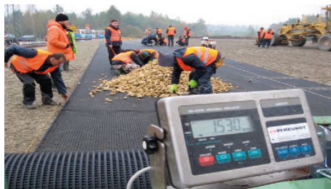
Rys. 8. Instalacja geosiatki Fortrac® R 1200/100 A (aramid) w warunkach kontrolowanego napięcia
