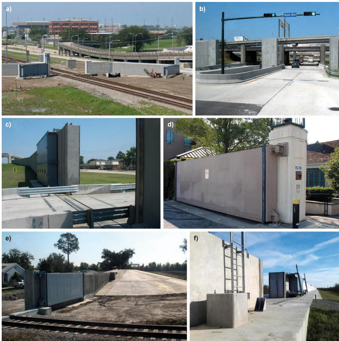
Rys. 4: Przejścia dróg komunikacyjnych przez groble przeciwpowodziowe (zdjęcia autora) a), e) przejścia torów kolejowych, b), c) przejścia dróg samochodowych, d), f) przejścia dla pieszych i zwierząt
