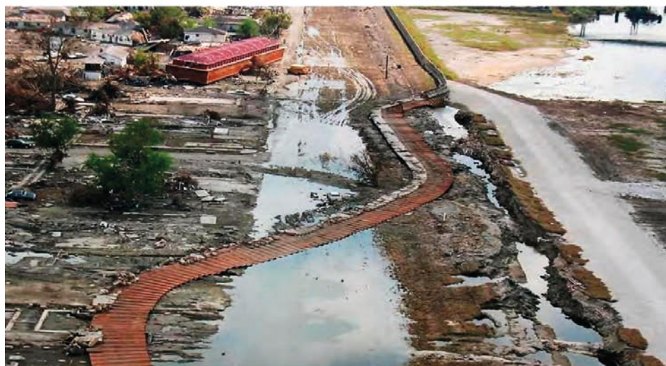
Rys. 1. Przykładowa awaria grobli kanału (zdjęcia USACE)
