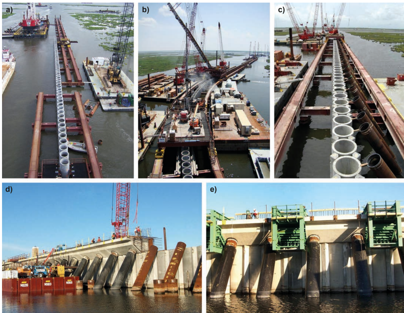
Rys. 6. Budowa bariery morskiej w Kanale IHNC (zdjęcia USACE)
