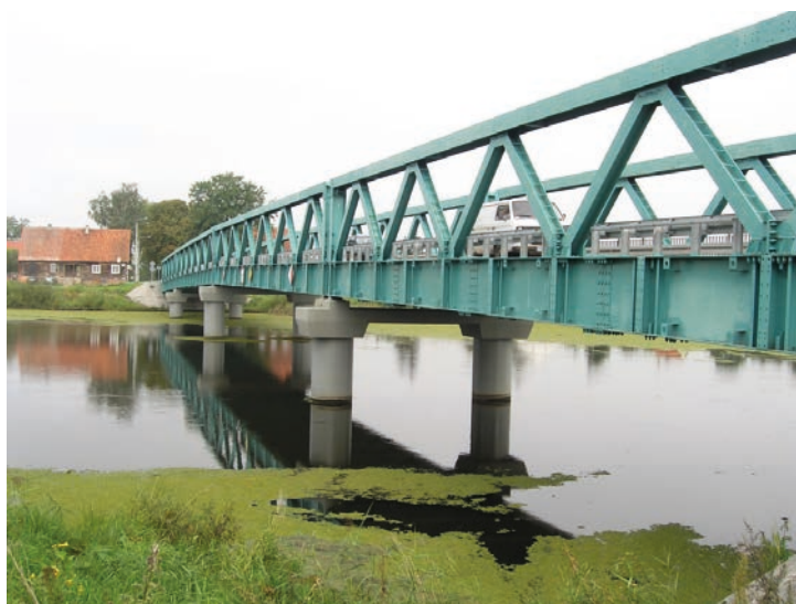
Rys. 12. Dwupalowe podpory mostu nad Nogatem
