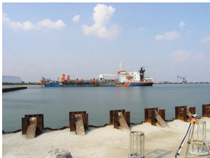
Rys. 11. Pale stalowe i pale Vibro w Terminalu Kontenerowym w Porcie Północnym w Gdańsku
