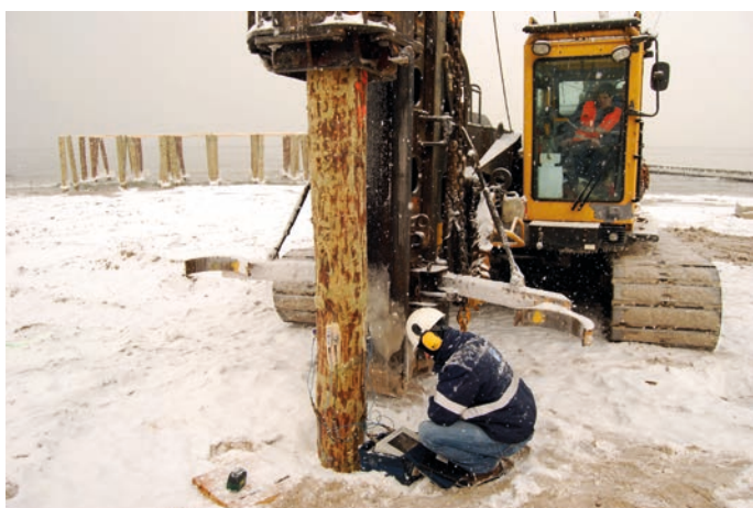
Rys. 14. Badanie dynamiczne pala drewnianego w Ustroniu Morskim (fot. Aarsleff)
