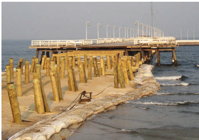
Rys. 13. Pale drewniane użyte do remontu moła w Sopocie
