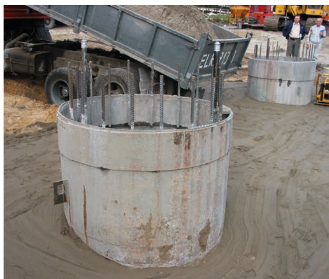
Rys. 12. Dwupalowe podpory mostu nad Nogatem
