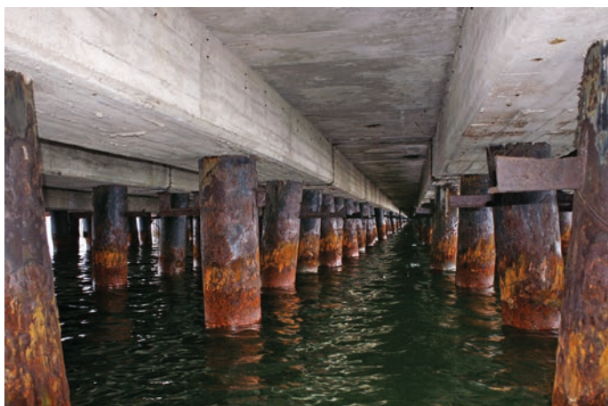
Rys. 4. Pirs Rudowy w Porcie Północnym w Gdańsku posadowiony na palach rurowych (fot. K. Mioduszewski)
