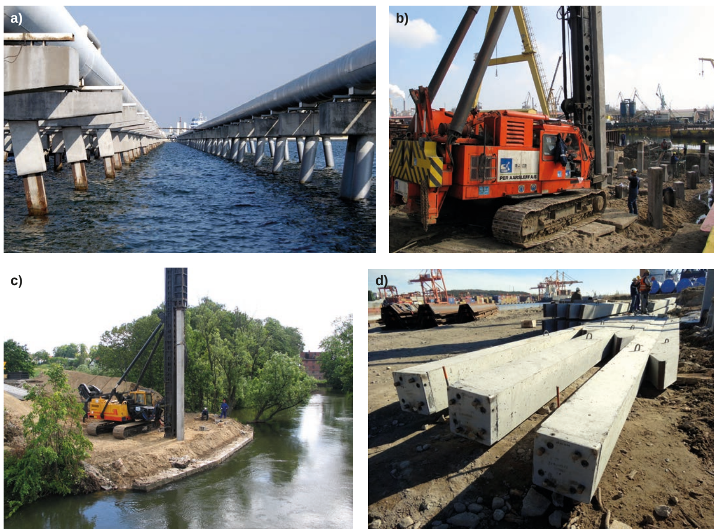
Rys. 1. Zastosowanie pali prefabrykowanych w konstrukcjach hydrotechnicznych
