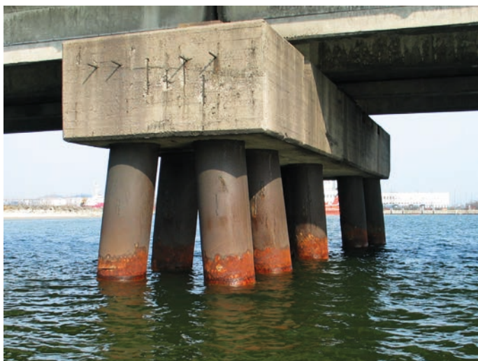
Rys. 5. Podpora Pirsu Węglowemu w Porcie Północnym na palach rurowych (fot. K. Mioduszewski)
