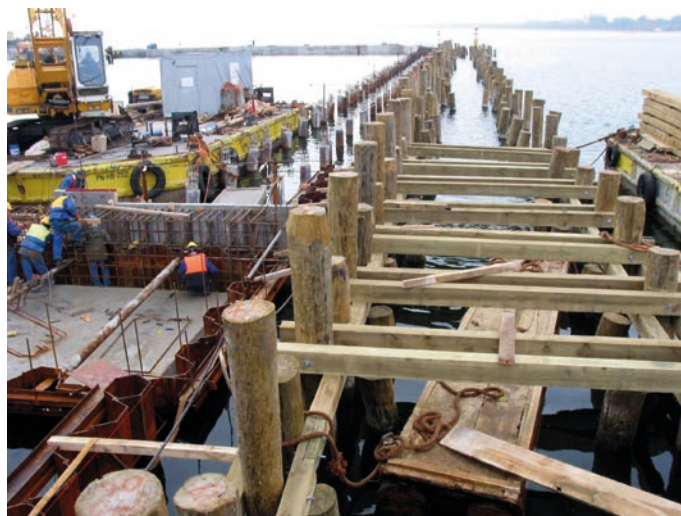
Rys. 3. Pale stalowe konstrukcji Mariny w Sopocie obok pali drewnianych zabytkowego moła
