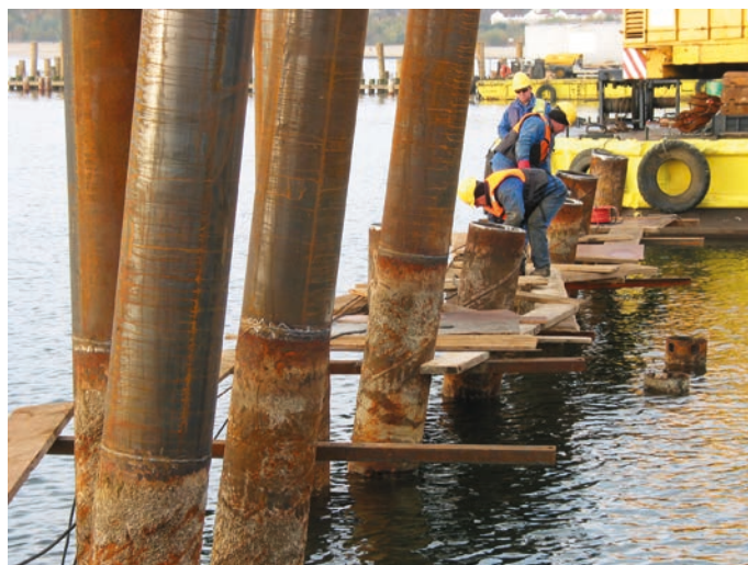
Rys. 2. Pale rurowe z dnem zamkniętym wykonane pod posadowienie Mariny w Sopocie
