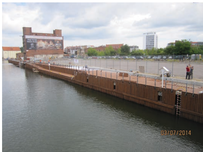
Rys. 8. Widok od strony Głównego Miasta nabrzeża Wyspy Spichrzów (część „B”) z obudową drewnianą konstrukcji nadbudowy nabrzeża
