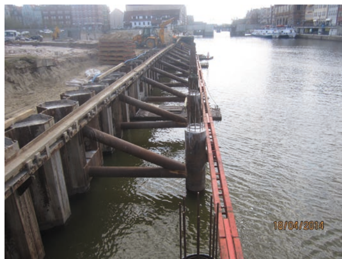
Rys. 7. Widok na część nadwodną nabrzeża pomostowego na Wyspie Spichrzów (od strony Głównego Miasta) – obie palisady połączone stężeniami z rur stalowych
