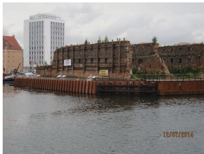
Rys. 9. Widok północnego cypla Wyspy Spichrzów z pozostawionymi (i chronionymi) ruinami dawnych budowli. Narożnik nabrzeża osłaniany konstrukcją „kierownicy” z rur stalowych
