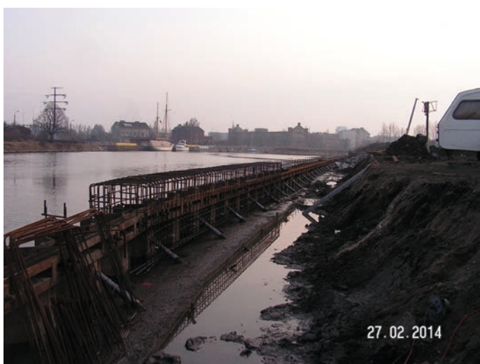
Rys. 4. Fragment budowy oczepu nabrzeża na lewym brzegu Kanału Motławy (część „A”)
