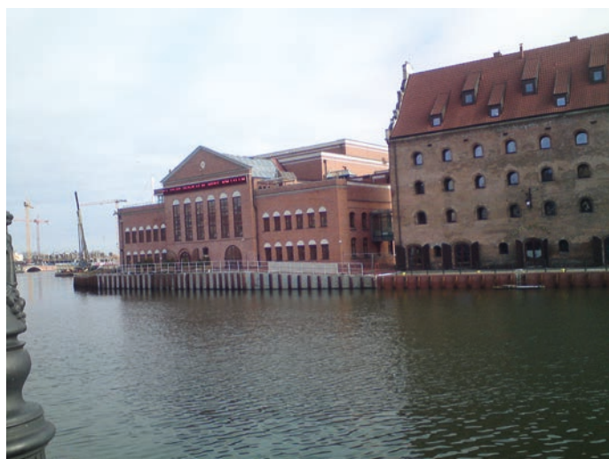
Rys. 17. Widok z Długoego Pobrzeża na nadbudowę przed hotelem Królewski i budynkiem filharmonii (dawnej elektrowni); licowanie ściany odwodnej nabrzeża cegłą klinkierową harmonizuje z istniejącymi budynkami – oba budynki zyskały dodatkową powierzchnię od strony akwenu, która może być ogólnym terenem bulwaru spacerowego na Wyspie Ołowianka
