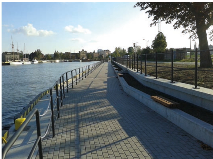
Rys. 3. Widok nadbudowy nabrzeża (z deptakiem) na lewym brzegu Kanału Motławy (część „A”)
