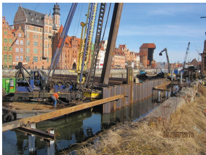
Rys. 6. Realizacja palisady (od strony lądu) na Wyspie Spichrzów (część „B”) przy budowie nabrzeża pomostowego (w tle widoczny żuraw – rozpoznawalny symbol Gdańska)
