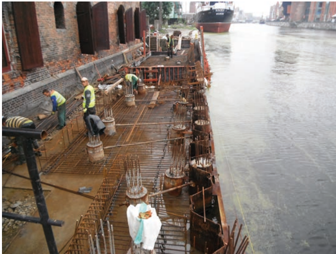
Rys. 15. Część podwodna nabrzeża pod hotelem Królewski przed wykonaniem nadbudowy konstrukcji
