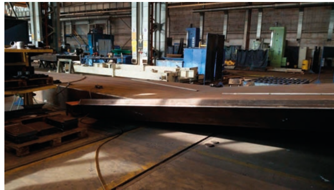
Rys. 3. Spawanie elementów konstrukcji stalowej urządzenia odbojowego
