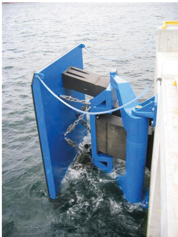
Rys. 1. Odbojnica z konstrukcją nośną (stalową) obrotową
