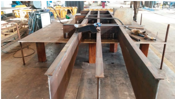
Rys. 2. Montaż konstrukcji stalowej
