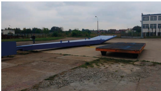
Rys. 8. Składowanie wyprodukowanej konstrukcji stalowej
