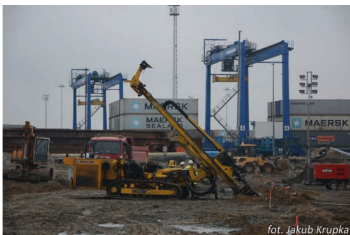
Rys. 17. Wiercenie mikropali
