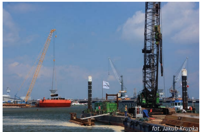
Rys. 4. Wbijanie ścianki podwodnej
