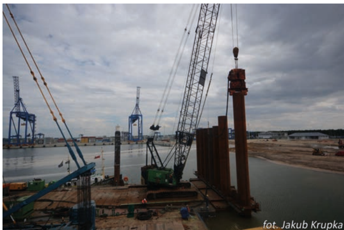
Rys. 9. Wbijanie rur stalowych w części wodnej
