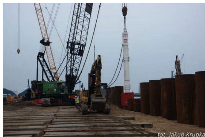
Rys. 13. Wbijanie rur stalowych w części lądowej
