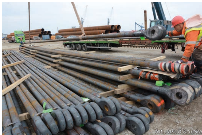
Rys. 18. Rozładunek ściągów stalowych
