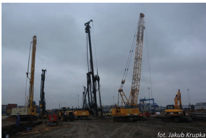
Rys. 16. Wiercenie pali CFA
