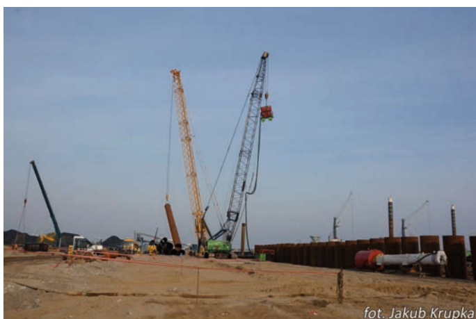
Rys. 11. Wbijanie rur stalowych w części lądowej
