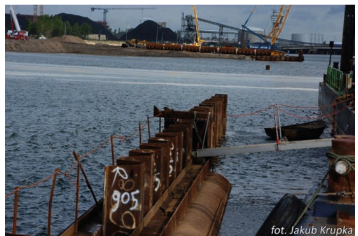
Rys. 5. Wbijanie ścianki podwodnej
