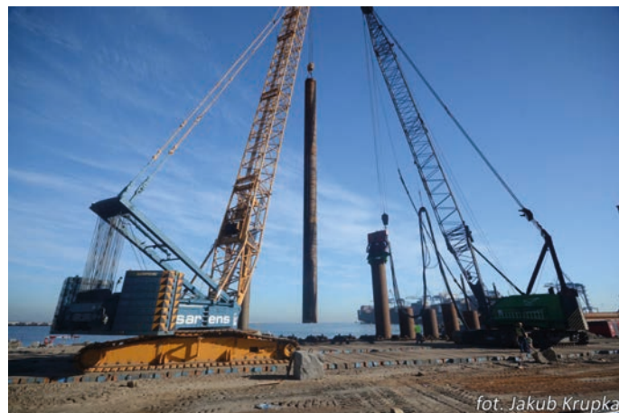
Rys. 12. Wbijanie rur stalowych w części lądowej
