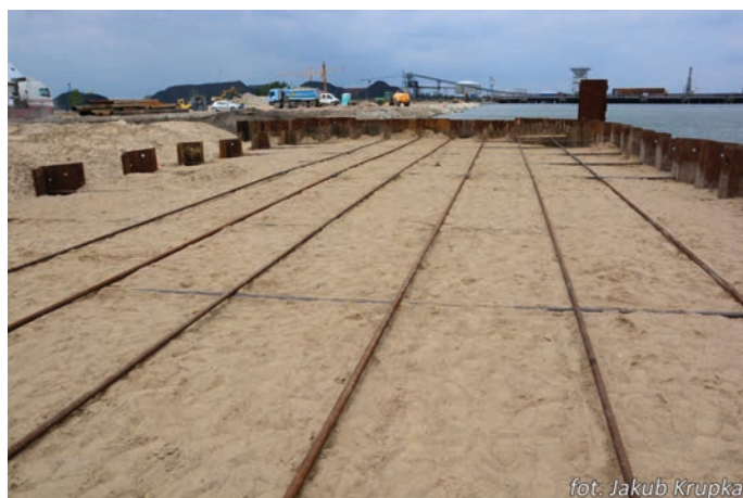
Rys. 6. Budowa przystani tymczasowej
