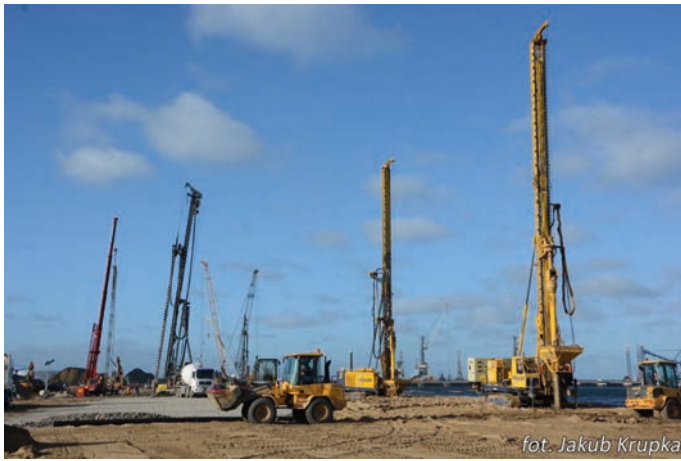
Rys. 3. Wykonywanie kolumn żwirowych
