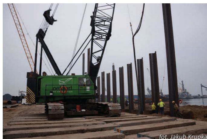
Rys. 14. Wbijanie ścianki w części lądowej
