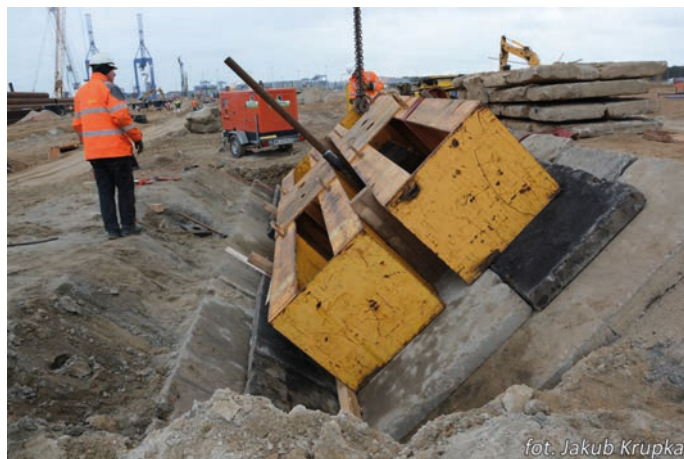
Rys. 23. Przygotowanie do badania na mikropalu
