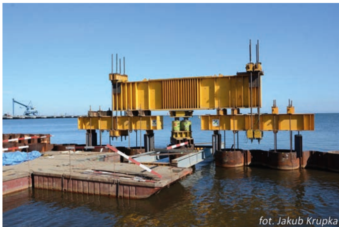
Rys. 21. Badanie statyczne na palu stalowym
