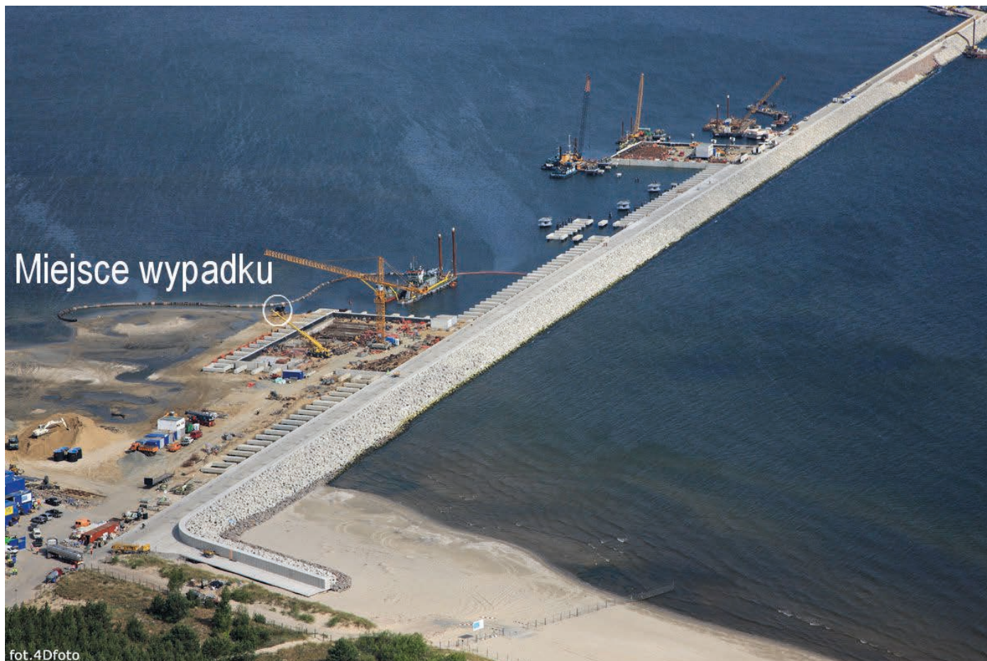
Rys. 2. Widok miejsca wypadku z czerwca 2012 roku, dwa dni po zdarzeniu. Zaawansowanie prac budowlanych
