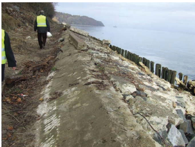
Rys. 7. Zabezpieczenie brzegu na odcinku III – stan istniejący
