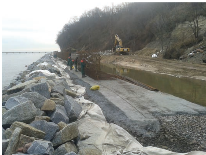
Rys. 14. Podbudowa pod ścianę oporową
