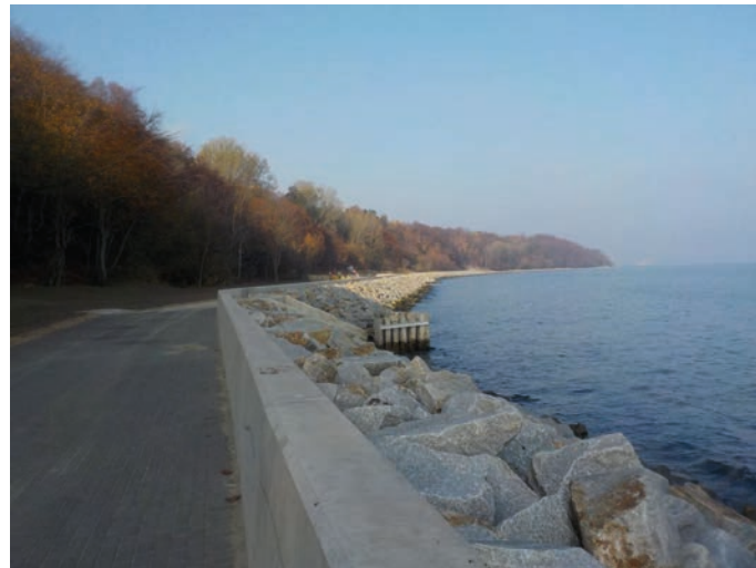
Rys. 18. Widok budowli zabezpieczającej (widoczny wylot cieku z zabezpieczeniem)
