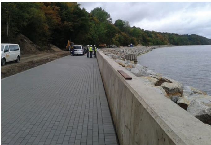
Rys. 17. Wykonana budowla ochraniająca brzeg
