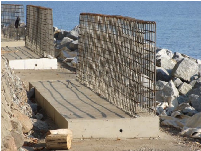
Rys. 15. Wykonywanie ściany oporowej (co drugą sekcję)
