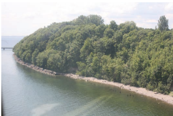
Rys. 6. Widok zabezpieczenia brzegu na odcinku I – stan istniejący
