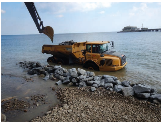
Rys. 12. Roboty rozbiórkowe na odcinku I
