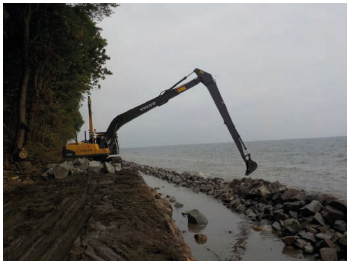
Rys. 13. Układanie narzutu kamiennego do poziomu +1,1 m
