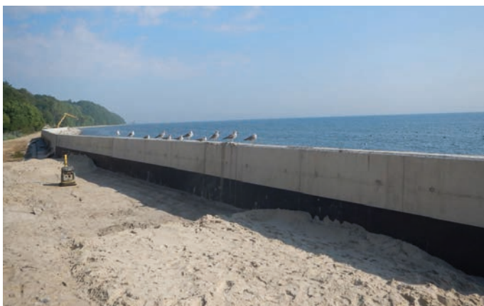
Rys. 16. Wykonanie ściany oporowej i zasypu od strony lądu
