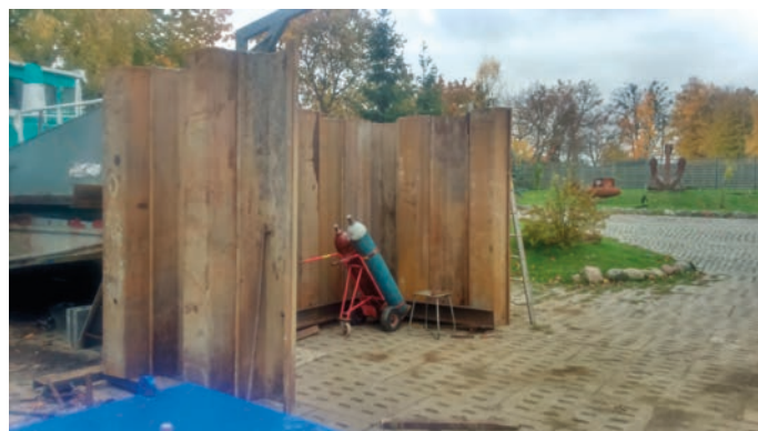
Rys. 6. Prefabrykacja na lądzie konstrukcji komory ujęcia wody
