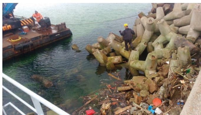
Rys. 2. Rozbiórka narzutu kamiennego osłaniającego falochron
