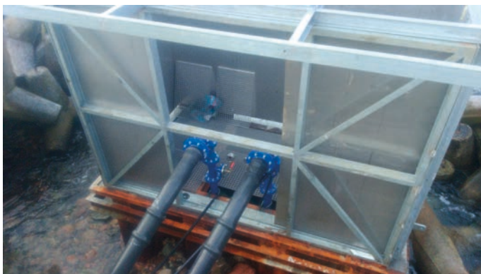
Rys. 10. Zamontowana instalacja pompowa
