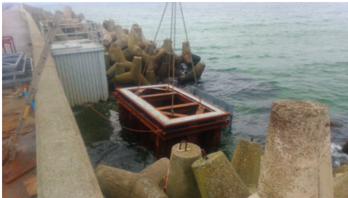
Rys. 8. Posadowienie konstrukcji komory ujęcia wody
