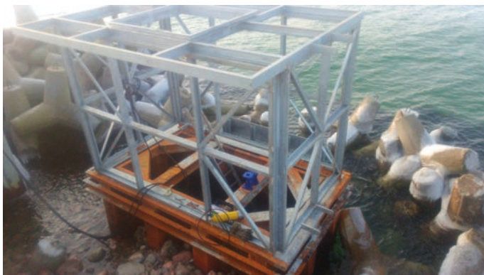
Rys. 9. Ustawienie komory ujęcia wody wraz ze szkieletem rusztu nadbudowy
