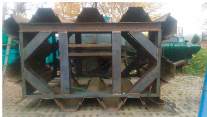
Rys. 7. Uzupełniające prace przy prefabrykacji (na falochronie) konstrukcji komory ujęcia wody
