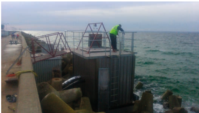
Rys. 11. Wykonane ujęcie wody morskiej
