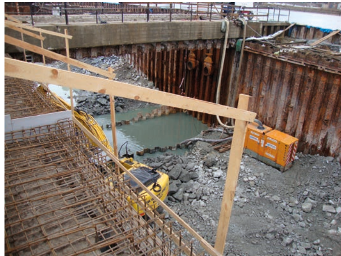
Rys. 10. Widok komory pomp po wycięciu ścianek szczelnych do poziomu dna grodzki wykorzystywanej, jako duża studnia odciażająca po udrożnieniu jej dna (fot. własna [9])
