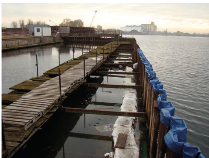
Rys. 2. Widok komory wschodniej doku i grodzki zewnętrznej od strony Kanału oraz bramy wschodniej doku i Nabrzeża Przemysłowego przed rozpoczęciem robót rozbiórkowych (fot. własna)
