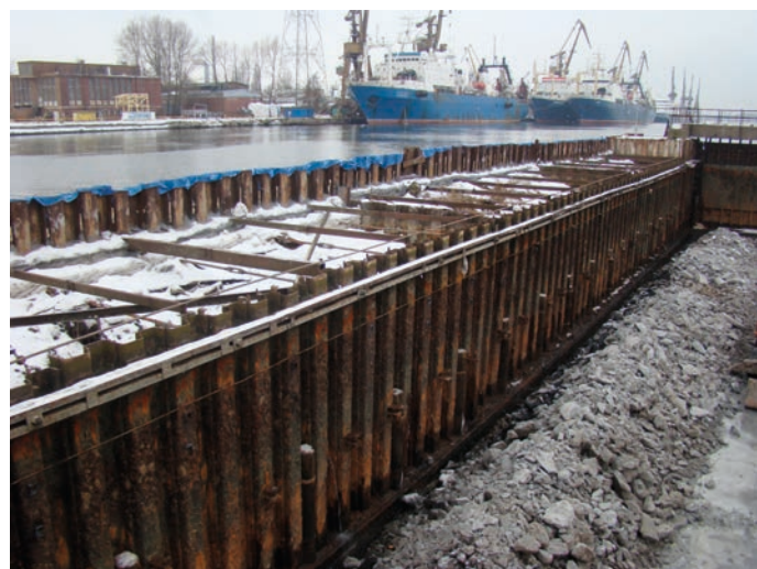
Rys. 3. Widok komory zachodniej doku i grodzki zewnętrznej grodzki od strony kanału po rozpoczęciu rozkuwania płyty dna doku (fot. własna [9])
