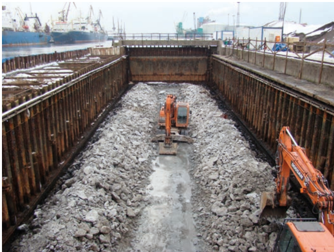
Rys. 9. Widok osuszonej zachodniej komory doku po rozpoczęciu robót rozbiórkowych rzędna dna -4,82 m n.p.m. Na wprost widoczna brama doku, po prawej stronie skorodowana ścianka szczelna Nabrzeża Przemysłowego, po lewej stronie ścianka grodzki zewnętrznej (fot. własna [9])
