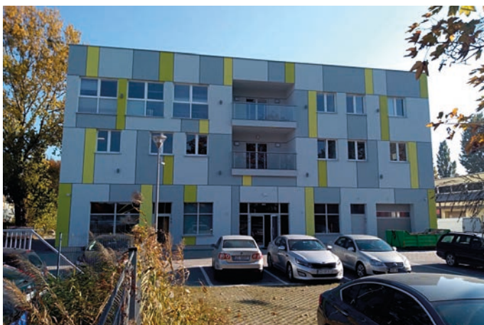
Rys. 5. Widok fasady czwartej (od roku 2018) siedziby BPBM PROJMORS w Gdańsku, budynek przy ul. Narwickiej 2D
