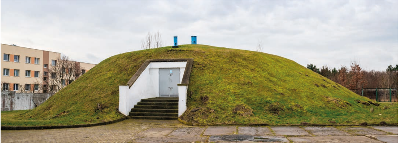
Rys. 3. Zbiornik wody „Obłuże” przy ul. A. Ledóchowskiego – stan 2019 rok (fot. Zbigniew Urbański, PEWIK Gdynia)
