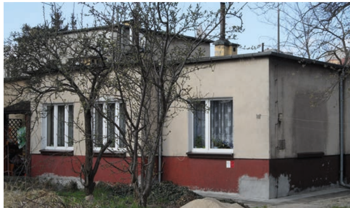
Rys. 2. Budynek mieszkalny przy ul. J. Śmidowicza nr 33 – dawny obiekt ujęcia wody „Oksywie”, stan 2018 rok (fot. Alicja Kulbik)
