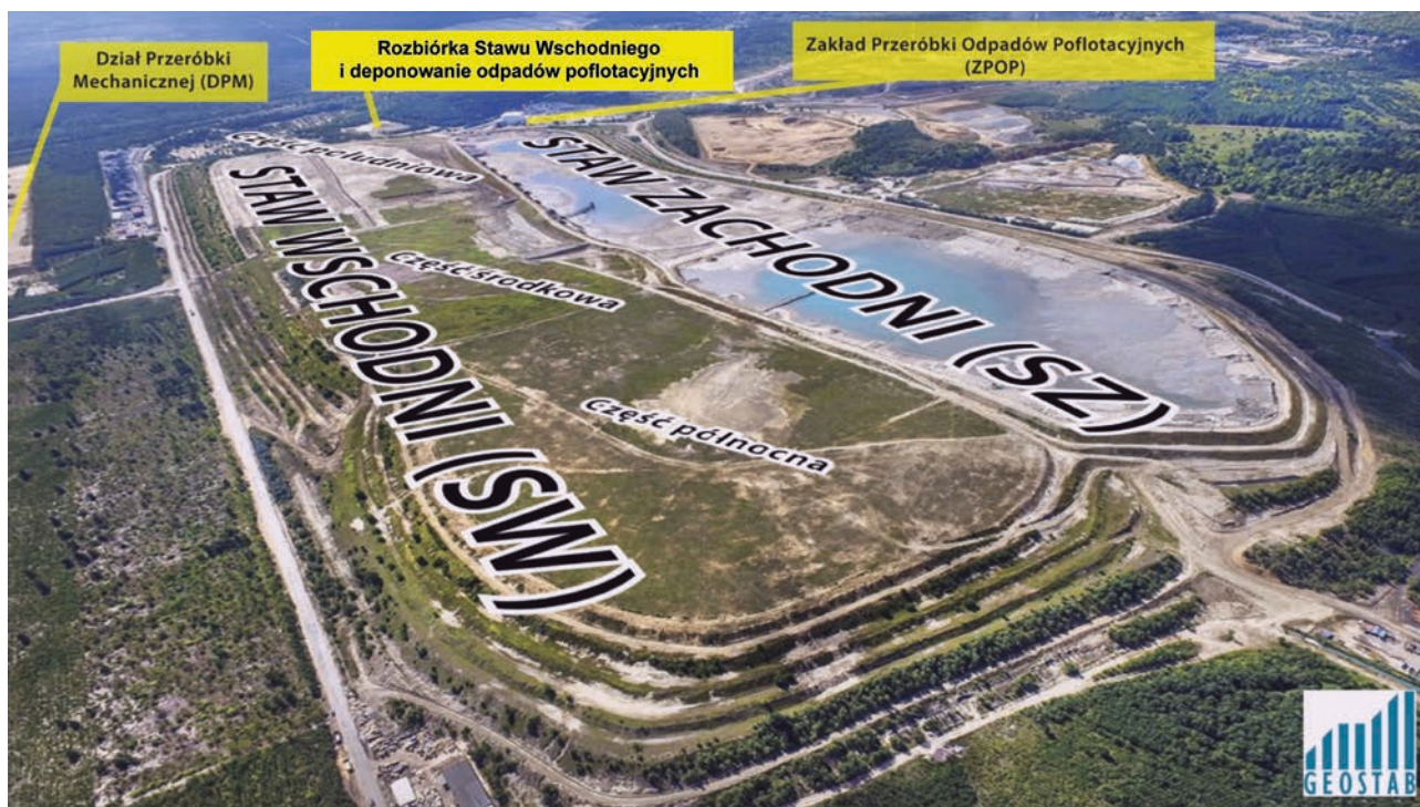
Rys. 1. Widok stawów przed rozbiórką od strony północnej
