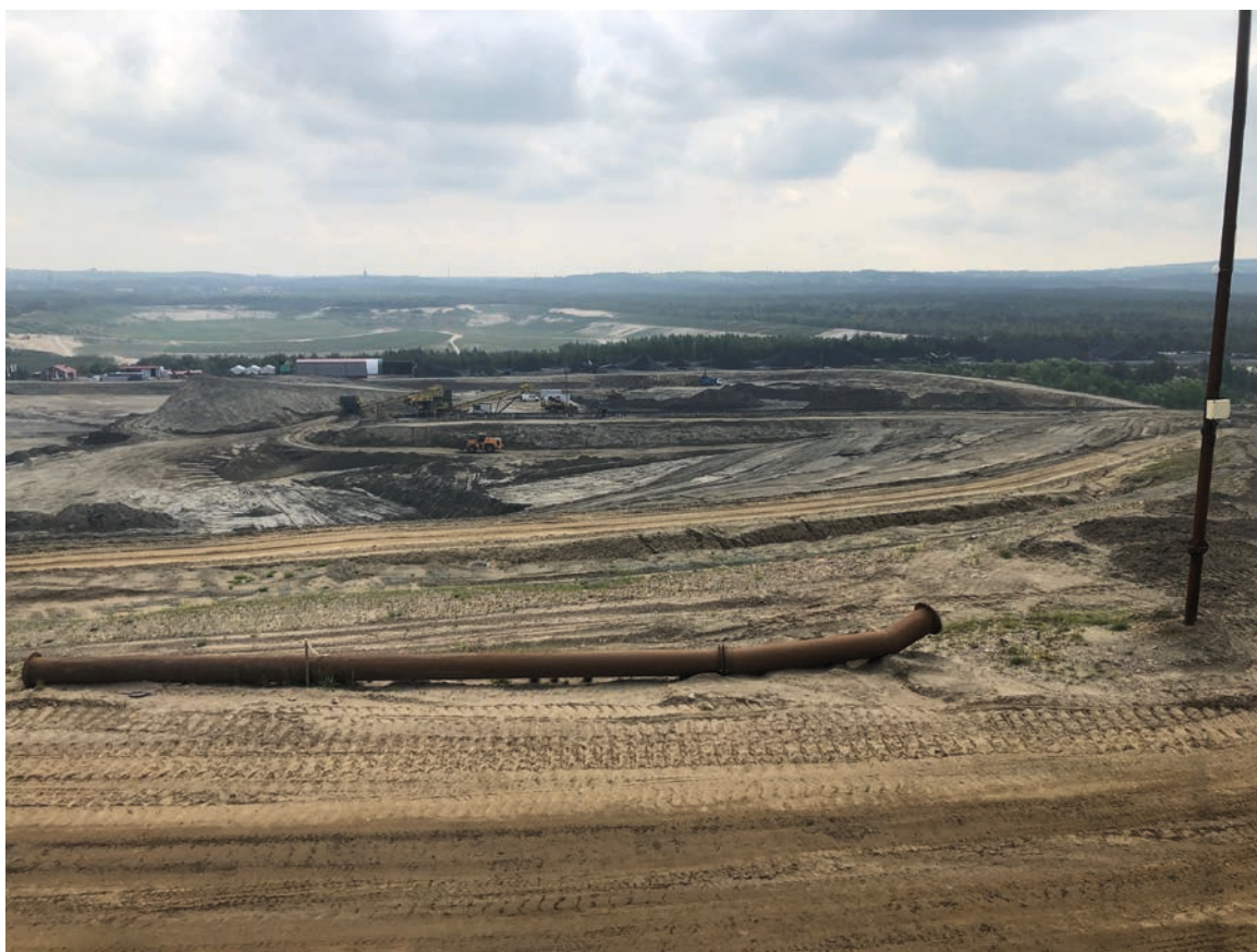
Rys. 9. Widok etapu końcowego rozbiórki części południowej Stawu Wschodniego – czerwiec 2019 roku
