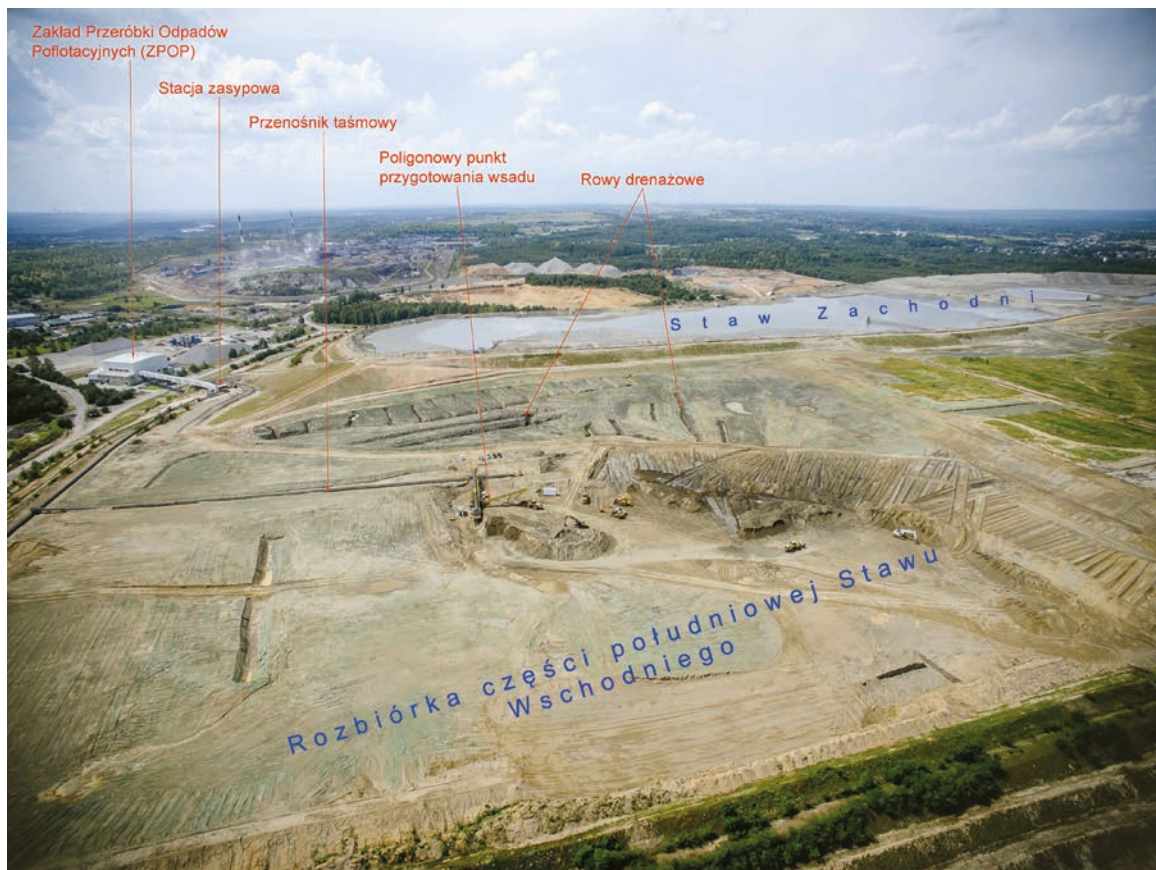
Rys. 8. Widok rozbiórki części południowej Stawu Wschodniego, widoczny przebieg taśmowy dostarczający odpady do ZPOP, w głębi eksploatowany Staw Zachodni
