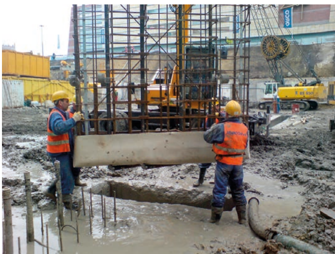
Rys. 7. Instalacja do iniekcji podstaw baret budynku przy ul. Złotej 44 w Warszawie
