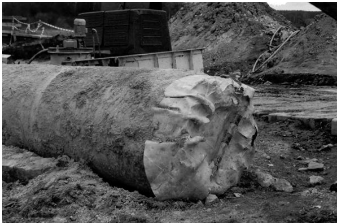
Rys. 6. Wyciągnięty pal z instalacją iniekcyjną Widoczny poziomy odcinek „U” rurki z opaskami gumowymi oraz przeponą separującą beton pala od gruntu i instalacji
