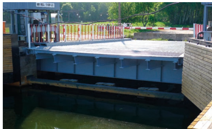
Rys. 14. Widok na wyremontowany pomost uchylny i nową belkę czołową na palach
