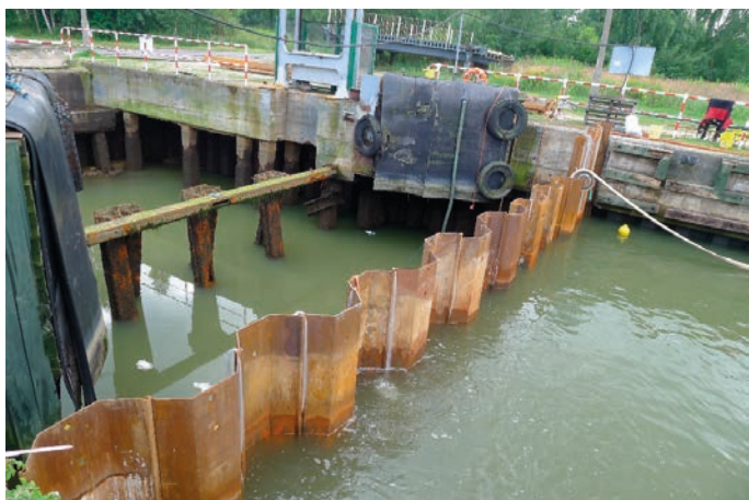
Rys. 6. Wygrodnienie wnętrza promowej ścianką z brusew Larssena
