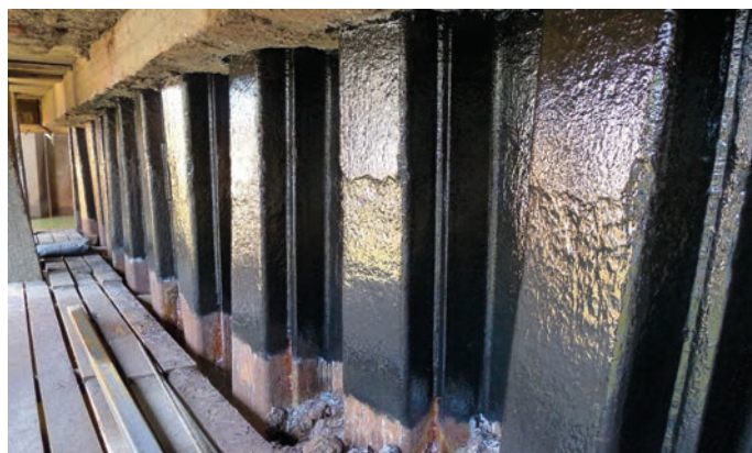
Rys. 8. Widok ścianki stalowej po wykonaniu zabezpieczenia systemem farb poliuretanowych
