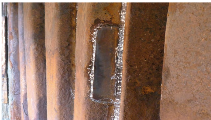
Rys. 7. Naprawa uszkodzeń korozyjnych i zaspawanie zamków ścianki szczelnej
