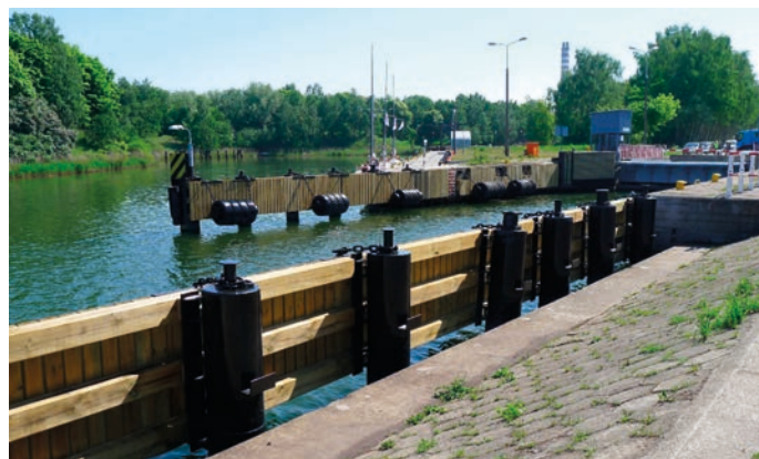
Rys. 13. Widok wyremontowanych konstrukcji prowadnic promowych
