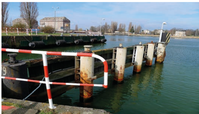
Rys. 1. Widok ogólny na wnękę główną i prowadnice przyczółku promowego
