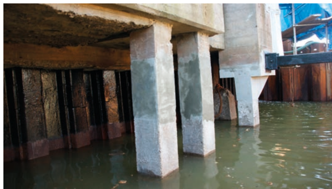
Rys. 9. Wyremontowana głowica i pale żelbetowe we wnętrze pomostu uchylnego
