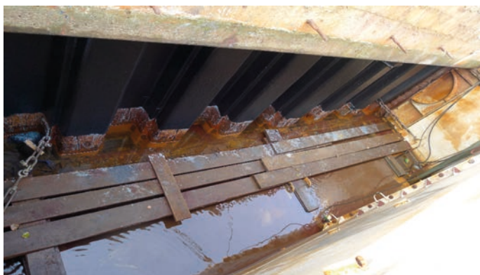
Rys. 11. Wyremontowana ścianka szczelna pod osłoną „plaskiej” komory roboczej
