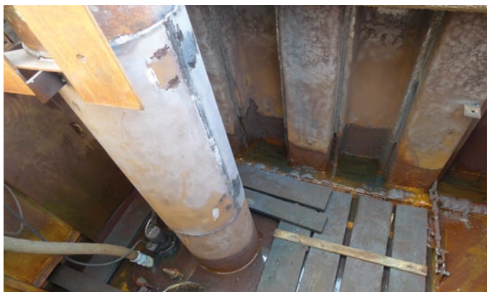
Rys. 10. Osuszony pal oraz fragment ścianki szczelnej przy stosowaniu jednej komory specjalnej (na palu widoczna jest założona stalowa „koszulka” wzmacniająca)
