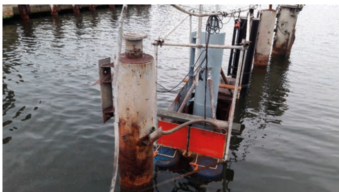
Rys. 12. Remont i zabezpieczenie antykorozyjne pojedynczych pali
