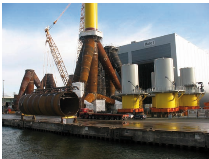
Rys. 2. Podstawy i elementy kolumn morskich turbin wiatrowych
