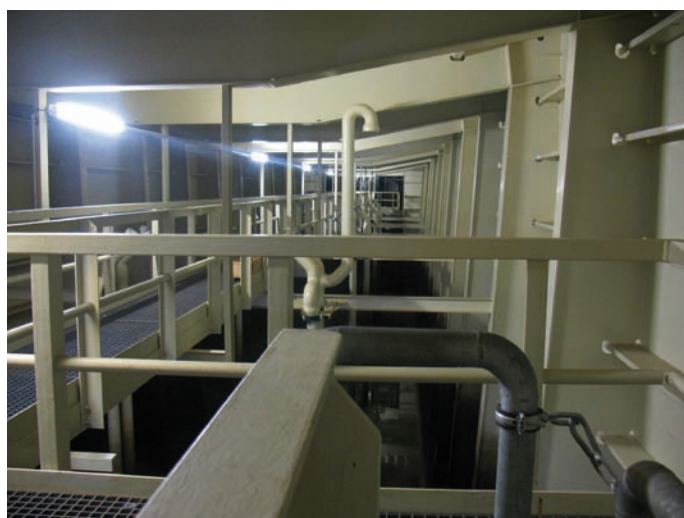
Rys. 9. Widok wewnątrz wrót śluzy
