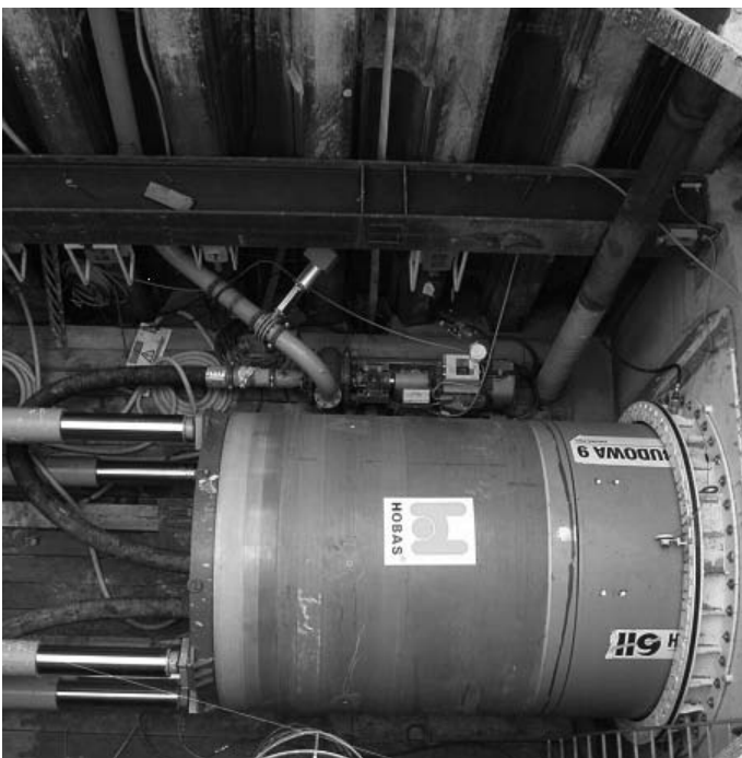
Rys. 4. Wprowadzanie kolejnej rury (materiały firmy HOBAS)
