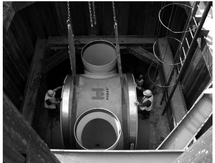
Rys. 5. Studzienka rewizyjna (GRP) wprowadzana do wnętrza komory dopiero po ukończeniu wierceń (materiały firmy HOBAS)
