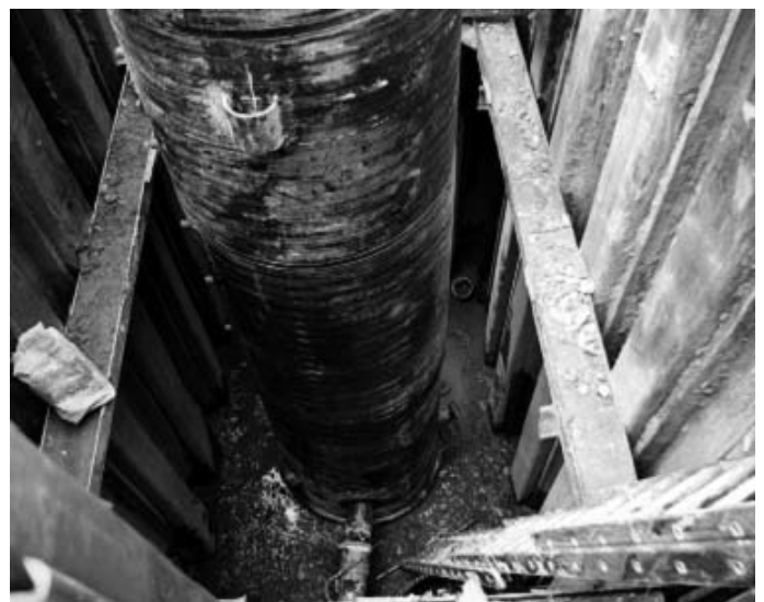
Rys. 5. Studzienka rewizyjna (GRP) wprowadzana do wnętrza komory dopiero po ukończeniu wierceń (materiały firmy HOBAS)
