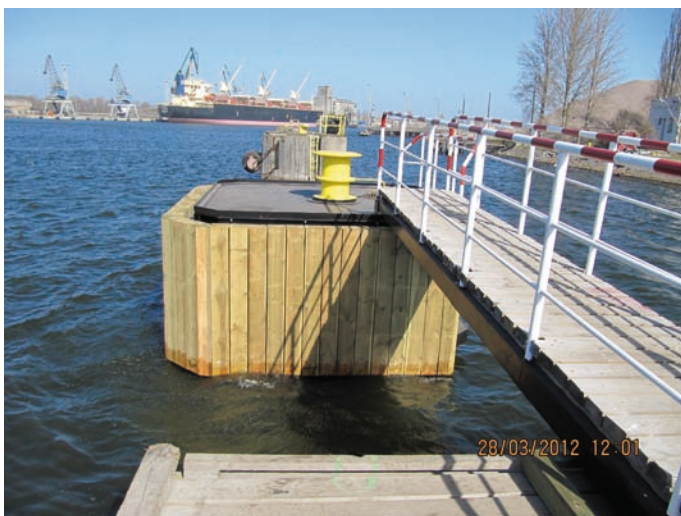
Rys. 11. Widok nowej dalby, odbudowanej po uszkodzeniu pierwotnej dalby nr 3 (z zainstalowaną ponownie kładką dojściową)
