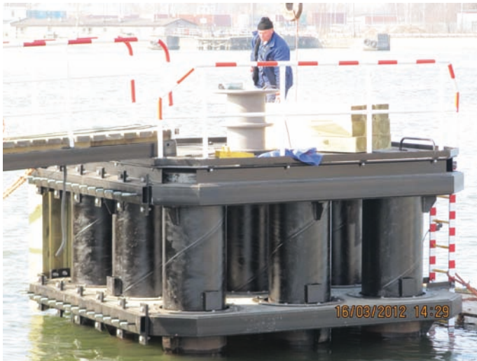
Rys. 9. Zmontowana konstrukcja nadbudowy dalby przygotowana do osadzenia belek odbojowych
