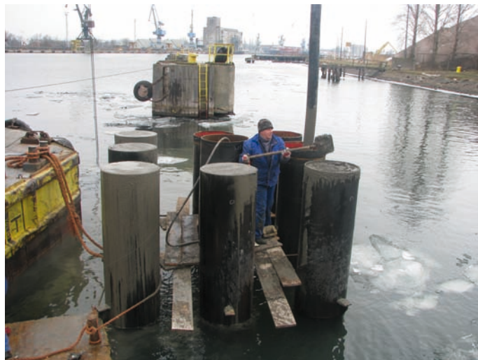
Rys. 6. Betonowanie części głowicowej pali dalby z wykorzystaniem pompy samochodowej do podawania betonu (widoczny, we wnętrzu jednego z pali, końcowy elastyczny odcinek rurociągu do podawania mieszanki betonowej)
