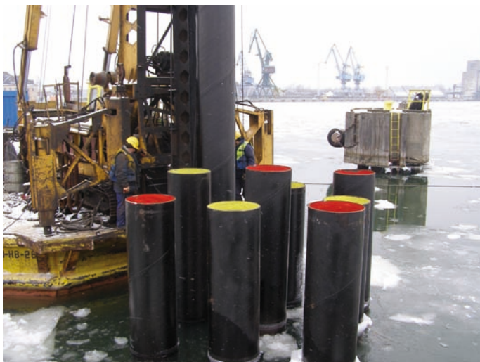
Rys. 4. Pograżanie pali kafarem pływającym (wnętrze pali wyróżniono kolorami: czerwonym – pale długości 22,5 m; żółtym – pale długości 20,5 m)
