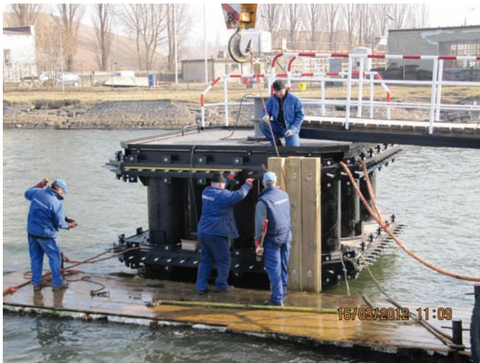
Rys. 10. Montaż drewnianych belek odbojowych na konstrukcji nadbudowy dalby
