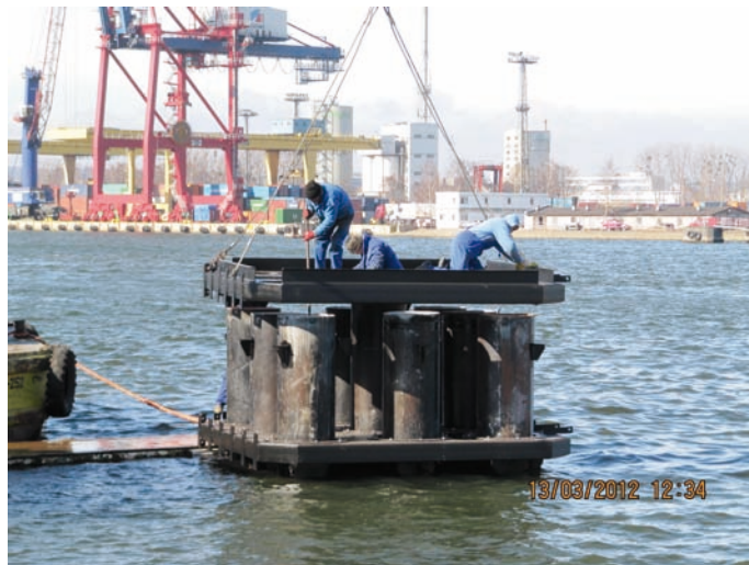
Rys. 7. Instalacja górnej obejmy na głowicach pali po zamontowaniu obejmy dolnej (w głębi widoczne nabrzeże Portu Gdańsk)
