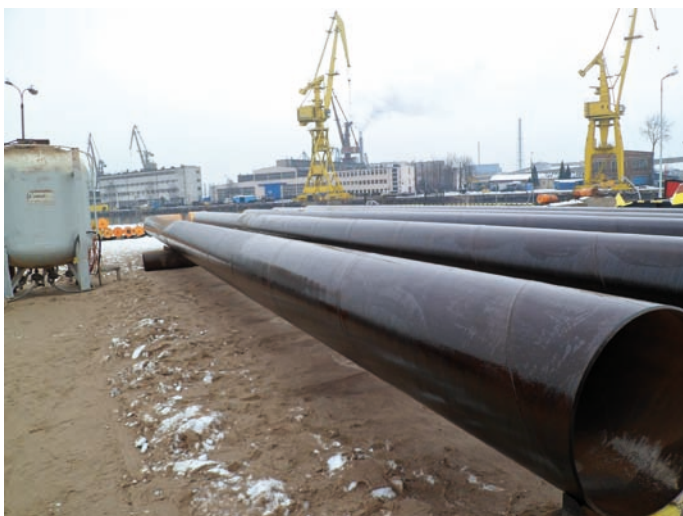
Rys. 5. Rury z przeznaczeniem na pale dalby, zabezpieczone antykorozyjnie na placu prefabrykacji (widoczna powłoka zabezpieczająca tylko na tej części rury, która po jej pograżeniu pozostanie powyżej dna)
