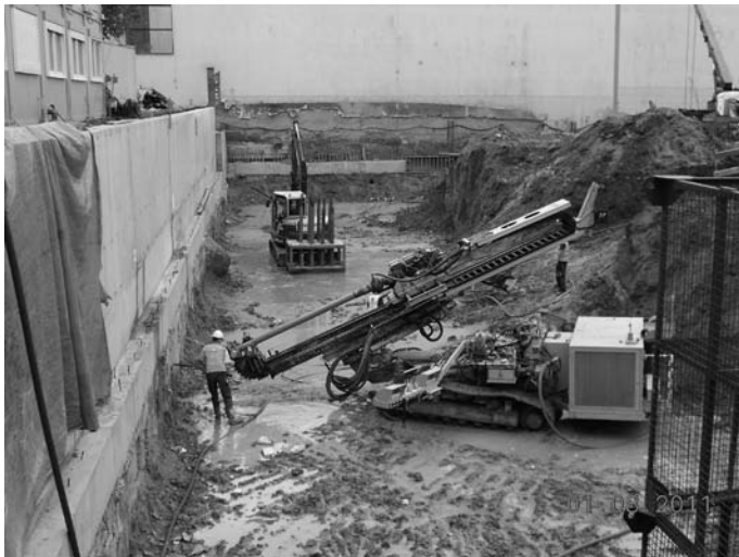
Rys. 3. Pracująca wiertnica do drążenia otworów pod kotwy gruntowe
