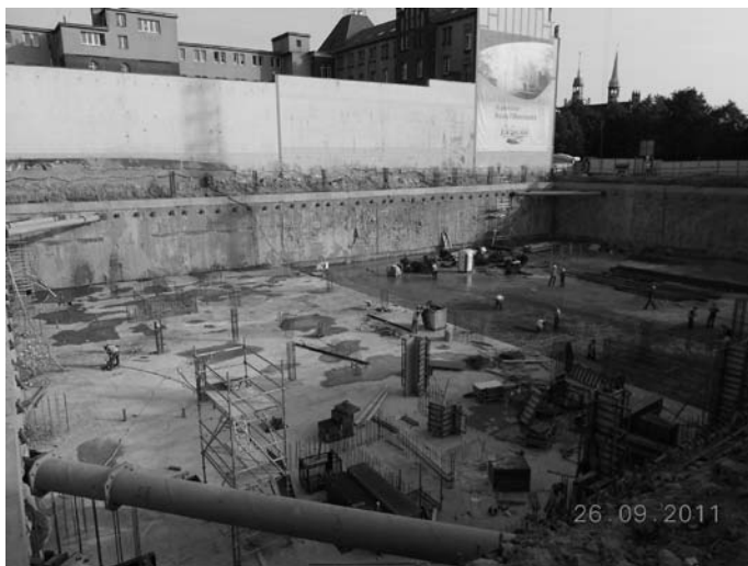
Rys. 6. Widok na obudowę wykopu z ścianek szczelinowych kotwionych wraz z rozporami w narożnikach
