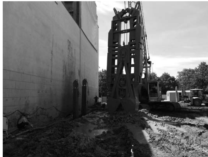
Rys. 2. Widok pracującego chwytaka do wykonywania ścian szczelinowych wraz z elementami rozdzielczymi przy budowie Filharmonii Szczecińskiej
