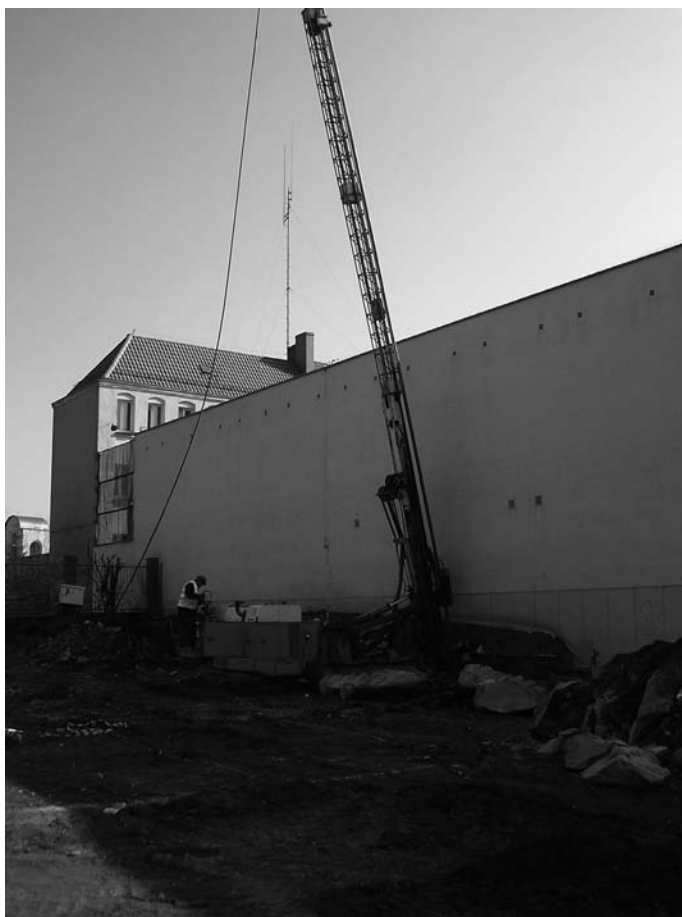
Rys 7. Widok pracującej wiertnicy przy wzmocnieniu podłoża gruntowego w technologii kolumn jet-grouting pod fundamentem budynku sąsiadującego z budową Filharmonii Szczecińskiej
