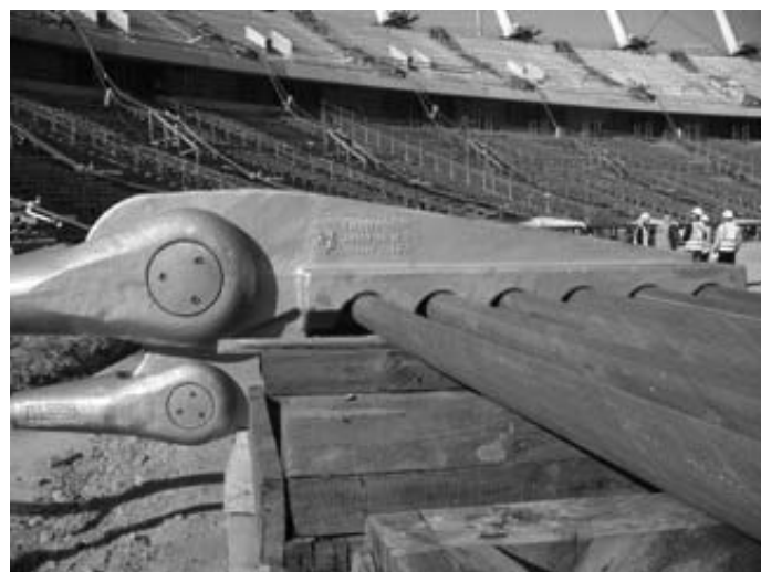
Rys. 2. Element mocowania lin, czyli tzw. „krokodyl”
