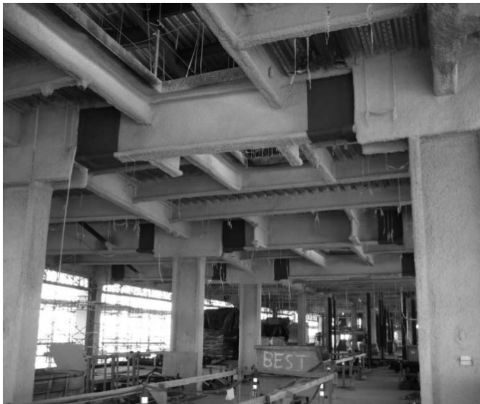
Rys. 2. Przykład zastosowania połączeń typu SidePlate ( http://www.sideplate.com , 04.2013)
