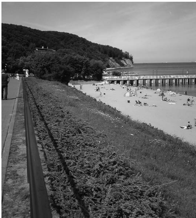
Rys. 8. Widok zrealizowanego umocnienia brzegu po wykonaniu nasadzeń roślin na skarpie
