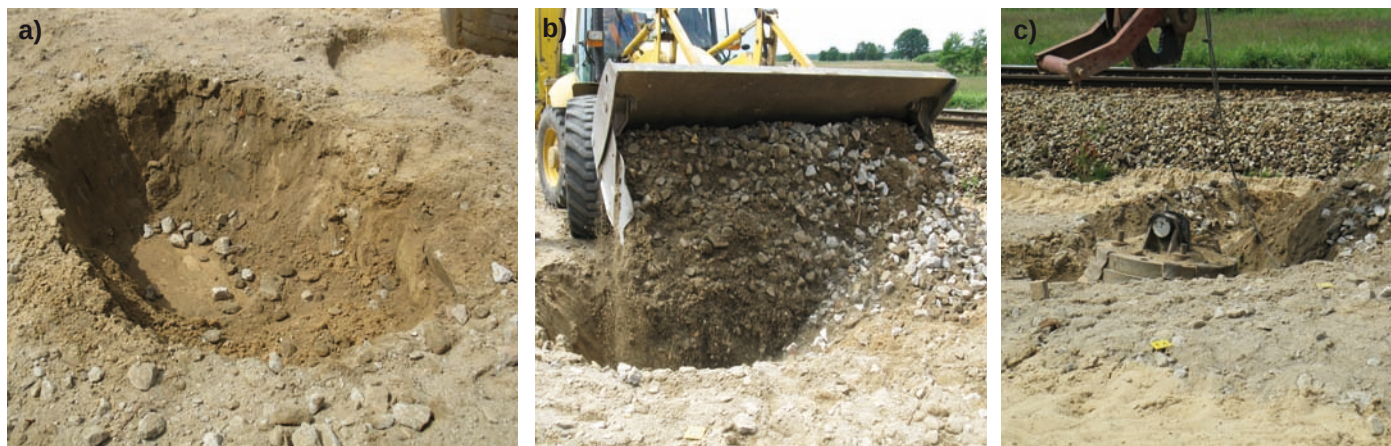
Rys. 6. Proces formowania kolumny: a) powstały krater, b) zasyp krateru, c) pełny wpęd ubijaka
