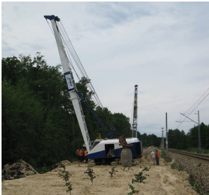
Rys. 5. Urządzenie dźwigowe wraz z ubijakiem do formowania kolumn
