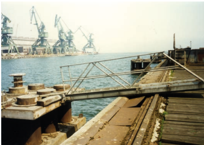
Rys. 9. Pirs Północny przy Nabrzeżu Duńskim (1996 r.) rozebrany w sierpniu 2005 r. (w marcu 2005 r. zakończono rozbiórkę dalb przy Pirsie Północnym)
