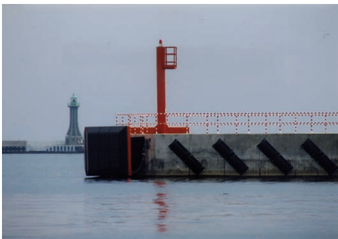
Rys. 3. Odbojnice na Ostrodze Pilotowej Południowej i światło nawigacyjne w dali – główka zielona Wejścia Głównego do Portu Gdynia (maj 2011 r.)
