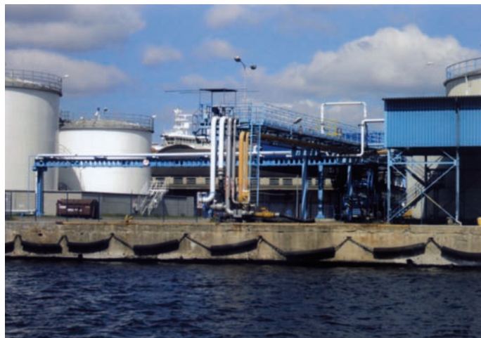
Rys. 19. Nabrzeże Indyjskie (zbiorniki firmy Westway) (lipiec 2013 r.)
