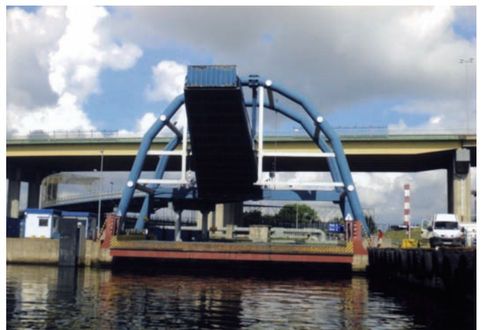
Rys. 24. Nabrzeże Helskie II. Rampa nr 2 (nad rampą ro-ro „B”) (2005 r.)
