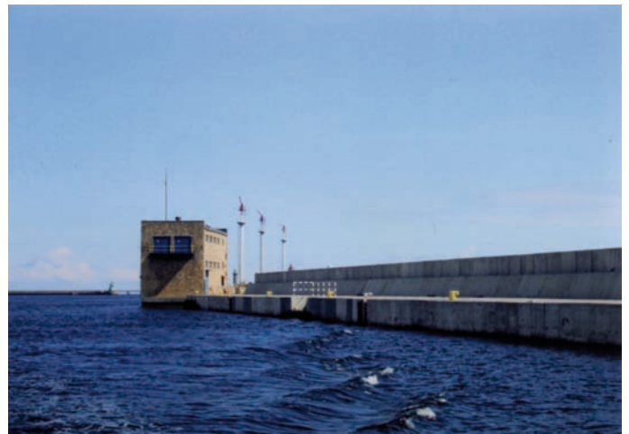
Rys. 13. Falochron Główny od strony Portu (lipiec 2013 r.)
