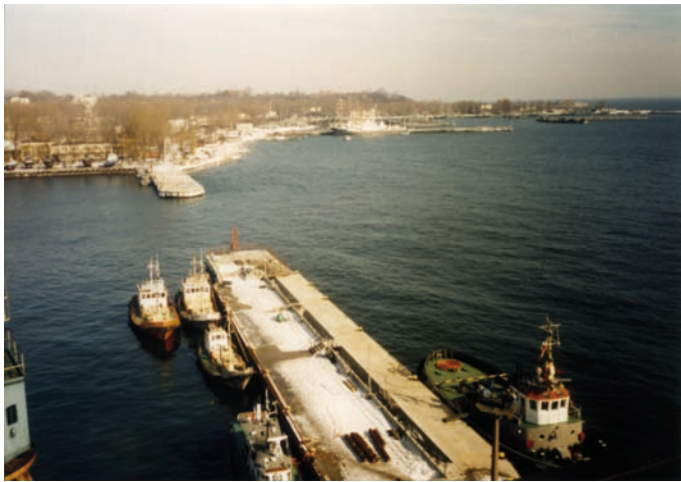
Rys. 2. Przebudowywana Ostroga Pilotowa Południowa (październik 1995 r.)
