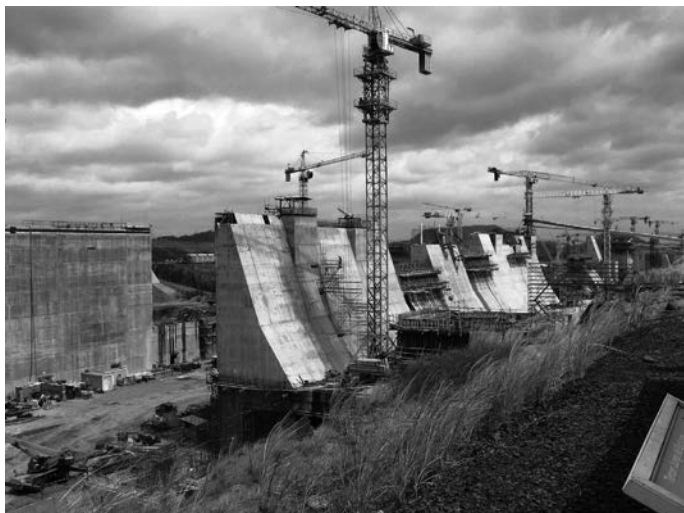
Rys. 1. Budowa nowych śluz w Kanale Panamskim, stan z czerwca 2013 (fot. autora)
