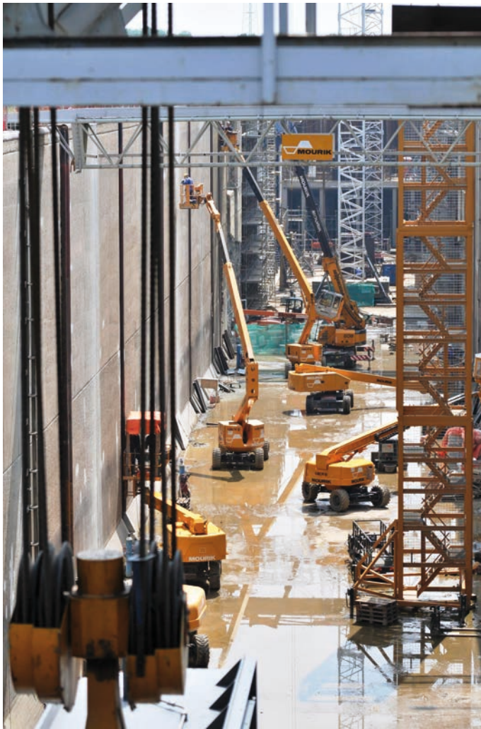
Rys. 3. Prace w komorze wydłużanej Śluzy Born, Kanał Juliany, Holandia (fot. autora)
