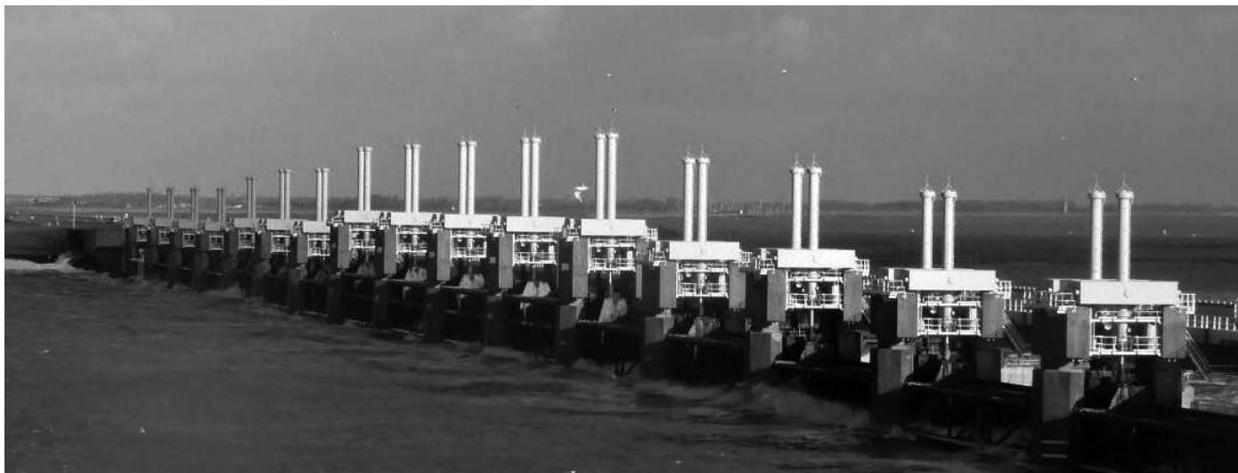
Rys. 13. Ruchoma bariera morska na Wschodniej Skaldzie z ustandaryzowanymi napędami zamknięć, Holandia
