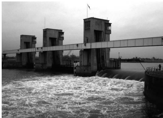
Rys. 6. Awaria przęsła Jazu Lith na Mozie, Holandia
