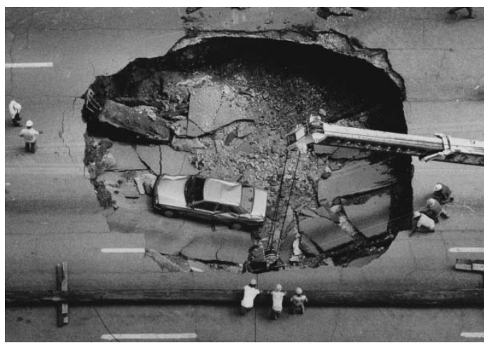
Rys. 5. Awaria kanału w Columbus [15]
