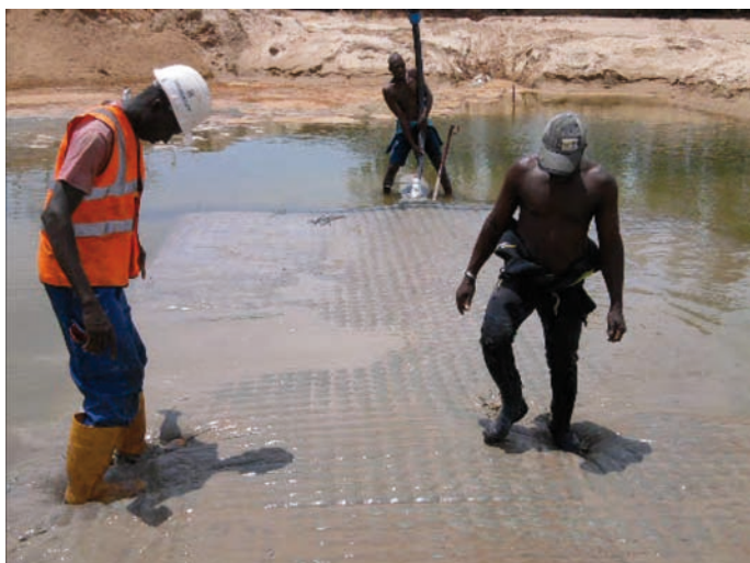
Rys. 26. Próbné napelnianie maty betonem na budowie
