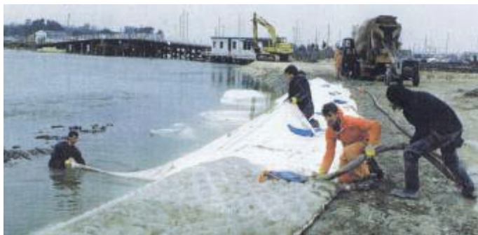
Rys. 17. Instalacja i napęnianie mat betonem
