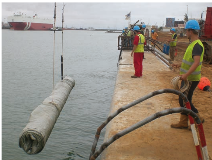
Rys. 25. Zatapianie maty w rolce; dalsza instalacja przez nurków
