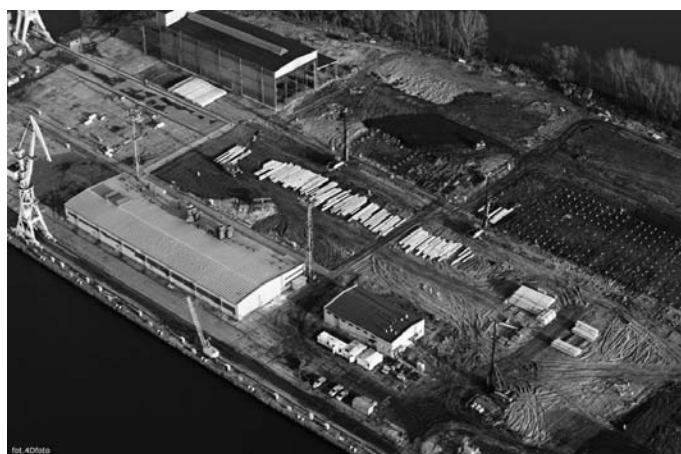
Rys. 6. Obszar po palowaniu (źródło: Bilfinger Crist Offshore [2])
