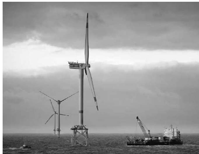
Rys. 10. Widok zamontowanych fundamentów i turbin wiatrowych (źródło: The building of an offshore wind farm, Alpha Ventus [10])
