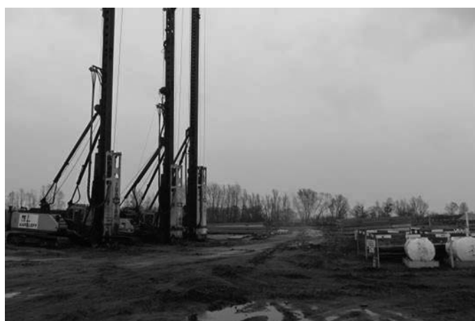
Rys. 5. Palowanie (źródło: Bilfinger Crist Offshore [2])
