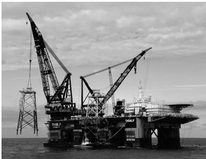
Rys. 9. Proces montażu fundamentu kratownicowego (źródło: The building of an offshore wind farm, Alpha Ventus [10])
