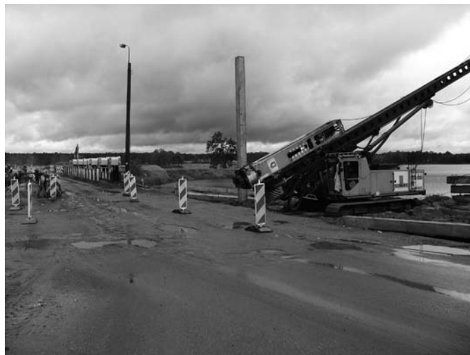
Rys. 1. Maszyna palująca JUNTAN PM20, zainstalowany pal prefabrykowany i istniejący most drogowy
