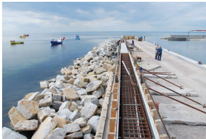
Rys. 16. Falochron wschodni – prace zbrojarskie i betonowe na parapecie (fot. z archiwum Urzędu Morskiego w Gdyni)
