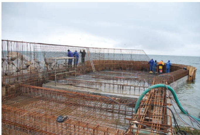
Rys. 15. Prace zbrojarskie na głowicy falochronu wschodniego (fot. z archiwum Urzędu Morskiego w Gdyni)
