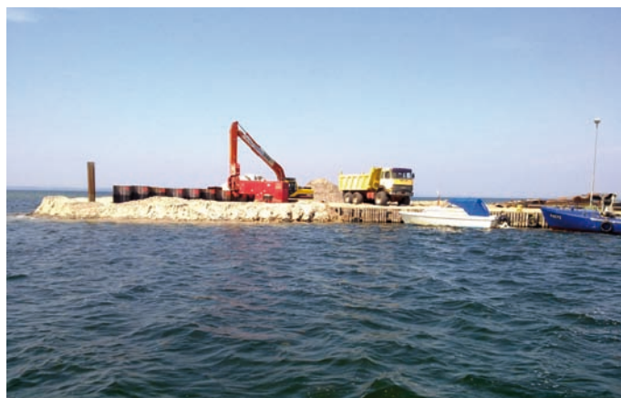
Rys. 17. Rozpoczęcie prac przy falochronie południowym (fot. z archiwum Urzędu Morskiego w Gdyni)
