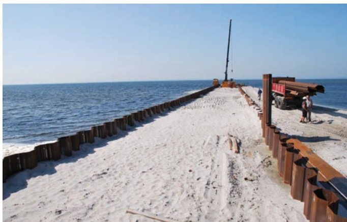
Rys. 14. Falochron Wschodni na końcowym etapie wbijania ścianek szczelnych (fot. z archiwum Urzędu Morskiego w Gdyni)
