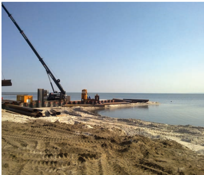
Rys. 13. Falochron Wschodni (fot. z archiwum Urzędu Morskiego w Gdyni)
