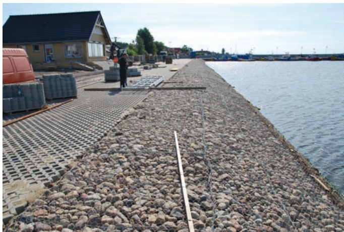
Rys. 19. Umocnienie brzegu (fot. z archiwum Urzędu Morskiego w Gdyni)
