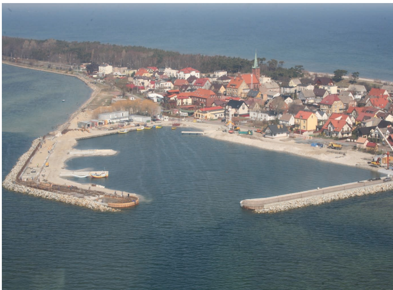
Rys. 21. Przystań Kuźnica w trakcie rozbudowy (fot. z archiwum Urzędu Morskiego w Gdyni)
